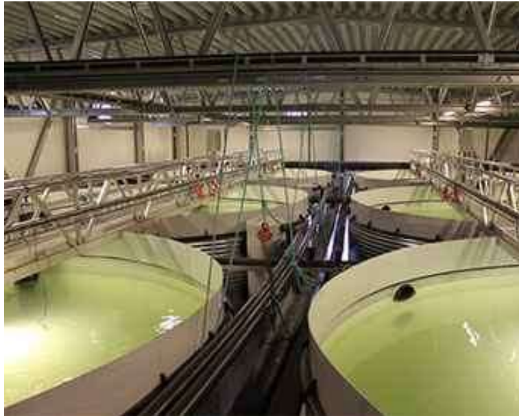
Figura 3. Tanques de acuicultura terrestre. (Háblame del mar). (Industria salmonera lidera el cambio hacia el cultivo en instalaciones terrestres, 2016)
