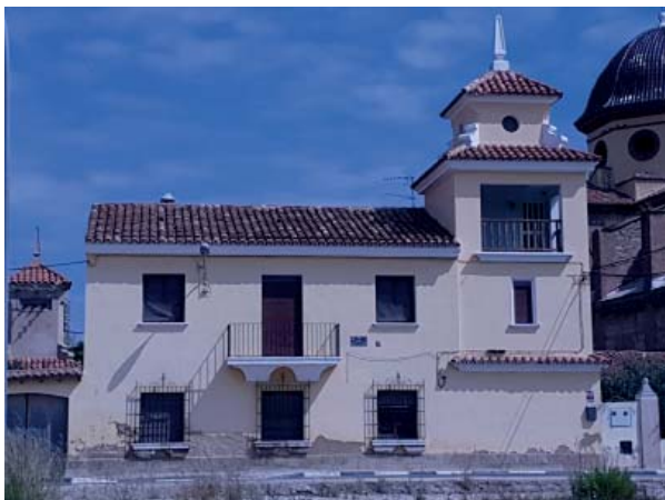
Fig.02.4.a: Torre anexa a alquería en el Camí de la Punta al Mar.
