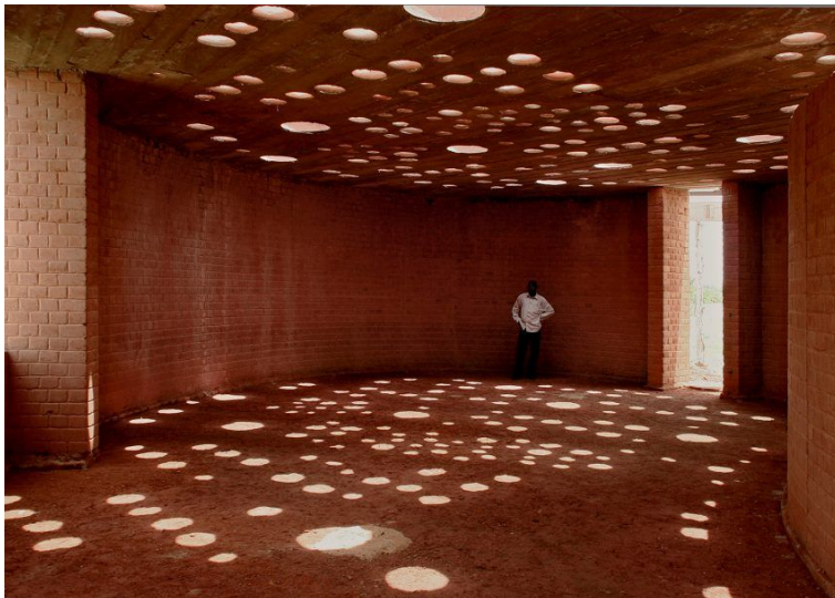
Fig.2. Colegio biblioteca en Gando
