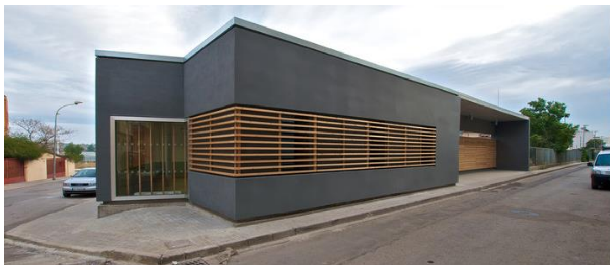
Fig.10 Imagen fachada norte con protección solar vertical y horizontal
