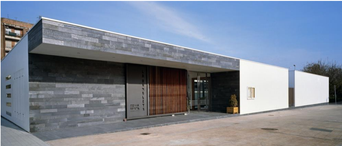
Fig.17 Imagen aulas orientadas al patio sur con protección solar de lamas horizontales
