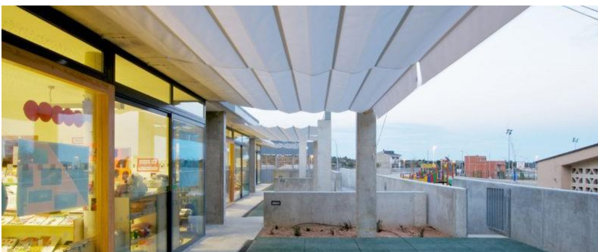
Fig.11 Imagen fachada oeste con protección solar horizontal
