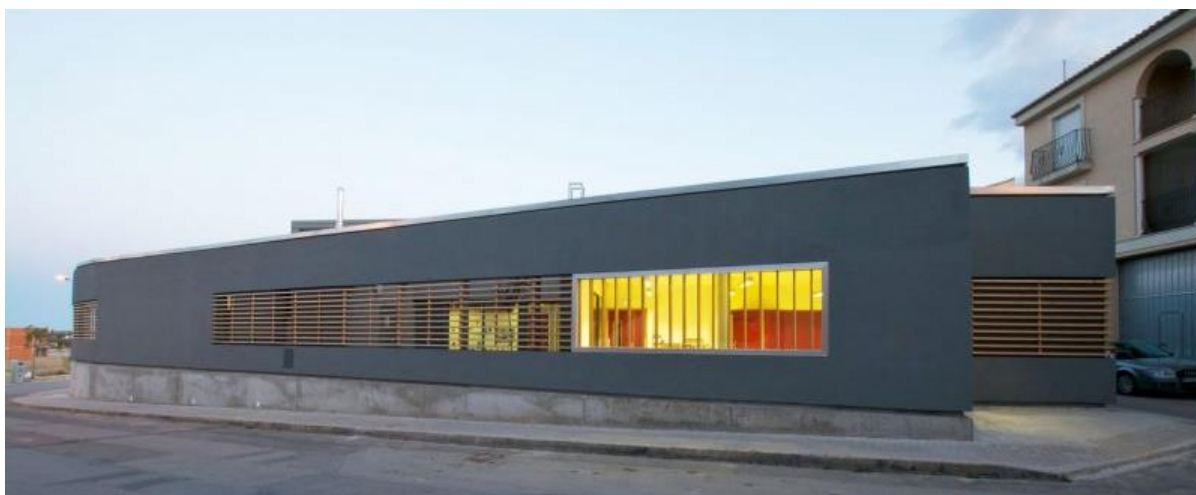
Fig.10 Imagen fachada norte con protección solar vertical y horizontal
