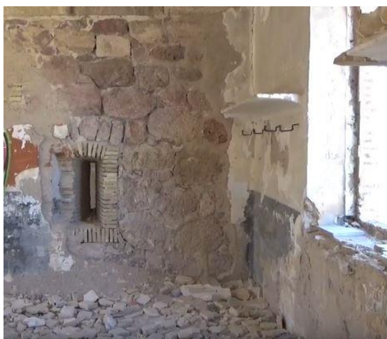
Figura 58: Vista de la aspillera tapiada del bloque Norte en la planta superior.
