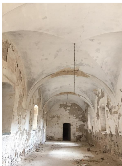
Figura 55: Vista del espacio diáfano en el ala Este mirando hacia el Norte.
