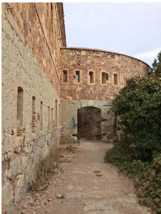
Figura 52: Vista de acceso al caponera Norte.
