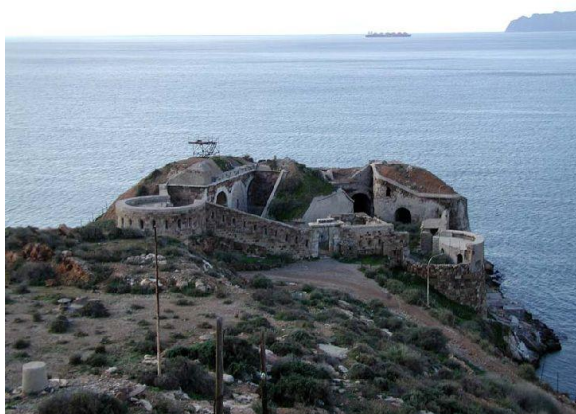
Figura 8: Batería Santa Ana Acasamatada (desde el monte de San Pedro).
