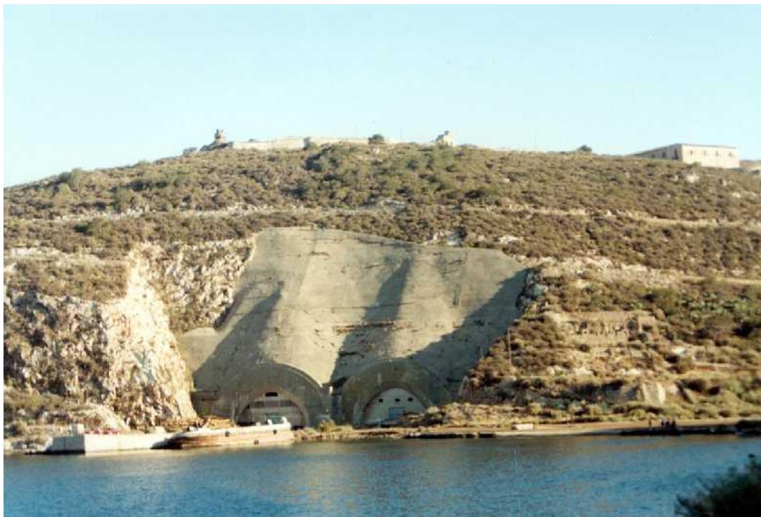
Figura 27: Vista desde la dársena del puerto de la entrada a los túneles submarinos. Fuente: http://www.aforca.org/fajardo_gf.htm
