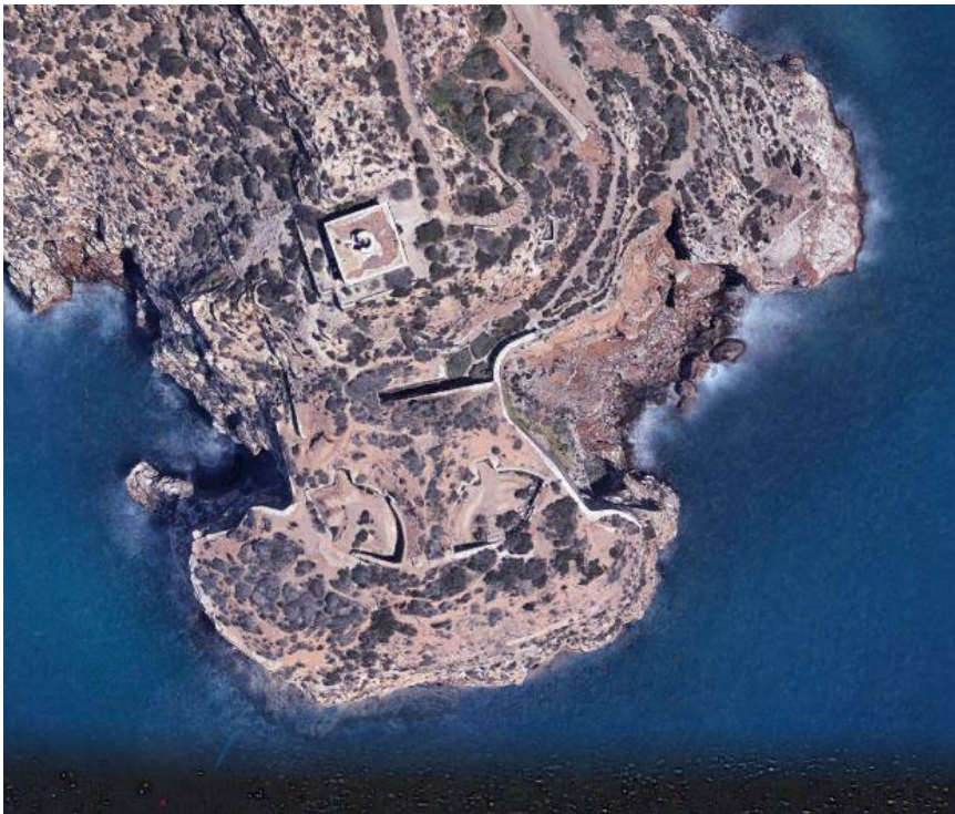
Figura 14: Ortofoto de la batería de la Podadera, el faro de la Podadera y el proyector nº1. Fuente: "Imagen tomada de Google Earth"
