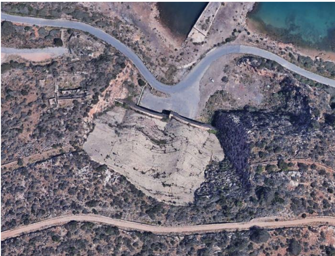
Figura 22: Ortofoto de la entrada a los túneles submarinos.
