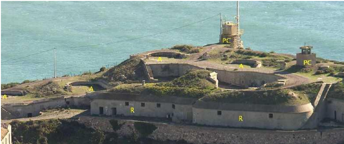
Figura 48: Fotografía de los repuestos y almacenes junto a la batería nº2 de Fajardo. Marcado con: repuestos (R), barbetas de los cañones (A), puestos de mando (PC).
