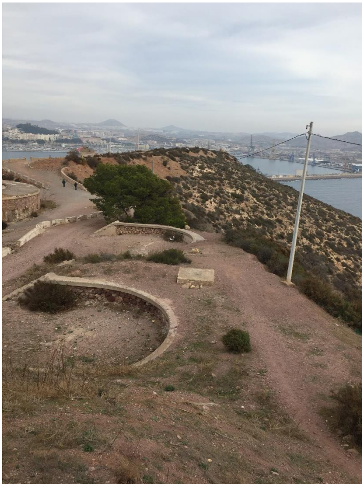
Figura 49: Vista de la batería nº2 de Fajardo; y nº3 al fondo.
