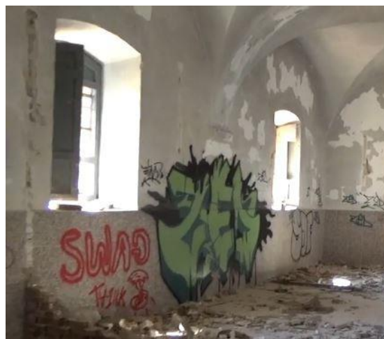
Figura 59: Vista de las aspilleras tapiadas en el ala oeste en la planta baja.
