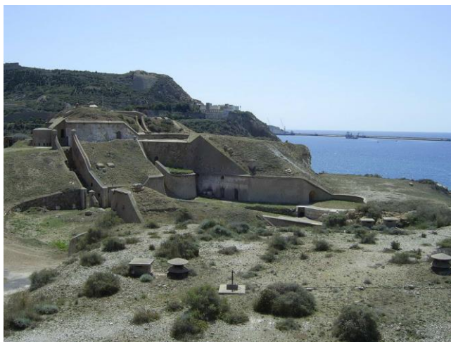
Figura 9: Batería Santa Ana Complementaria.
