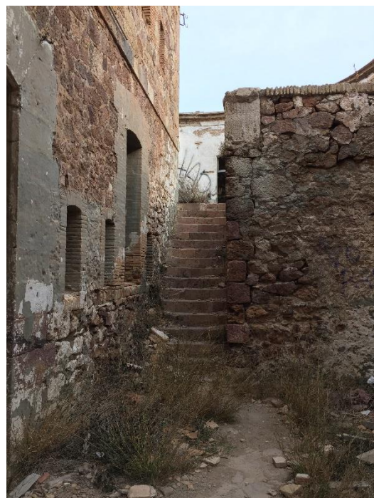
Figura53: Vista del acceso a la comunicación vertical caponera Norte.
