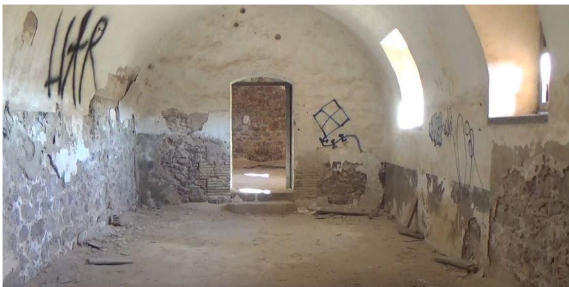
Figura 56: Vista del semisótano.
