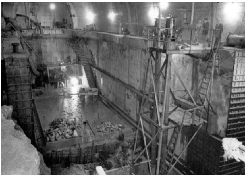
Figura 29: Construcción del foso del dique del túnel nº 1. Cartagena, 22 de diciembre de 1956. Fuente: http://www.armada.mde.es/archivo/rgm/2015/05/cap06.pdf
