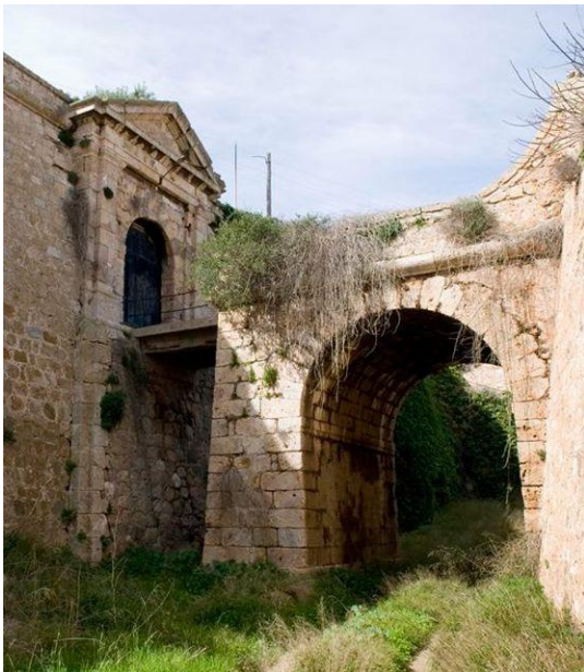
Figura 37: Vista desde el foso hacia el puente de acceso. Fuente: https://www.cartagena.es/detalle_agenda.asp?id=44249
