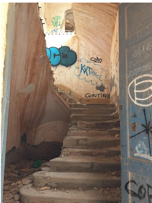
Figura 54: Vista de la escalera del bloque Sur de la caponera Norte.
