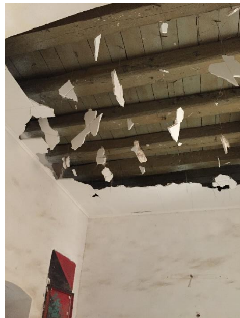
Figura 62 : Vista de viguetas de madera. Fuente: realizado por el autor de este TFG.
