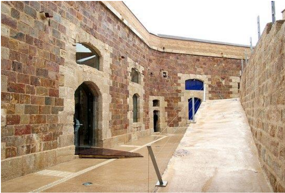
Figura 24: Vista desde el interior del patio del fuerte.
