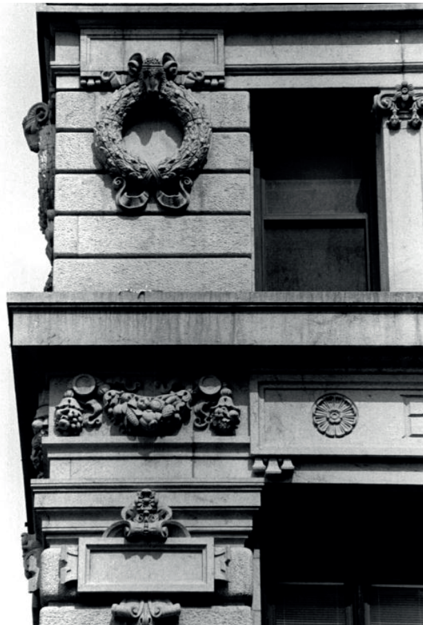
Imagen 3.100. Detalle de la base en la fachada de la calle Broadway.
