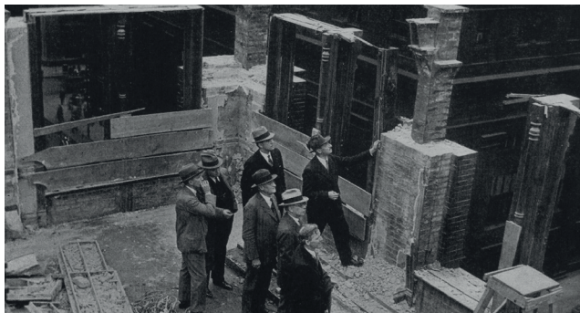
Imagen 3.2. Derribo del Home Insurance Building.
