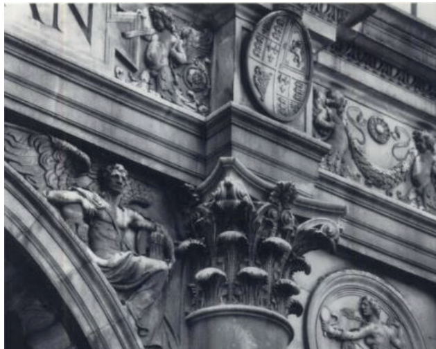
Imagen 3.71. Detalle del arco central de planta baja.
