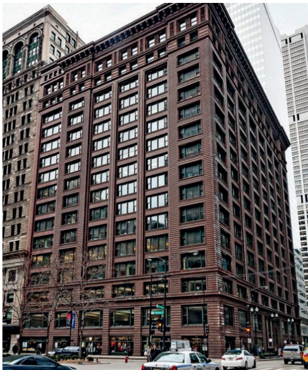
Imagen 3.47. El Marquette Building en la actualidad.
