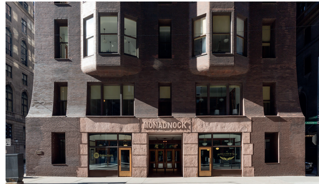
Imagen 3.18. Entrada del Monadnock Building de Burnham & Root.
