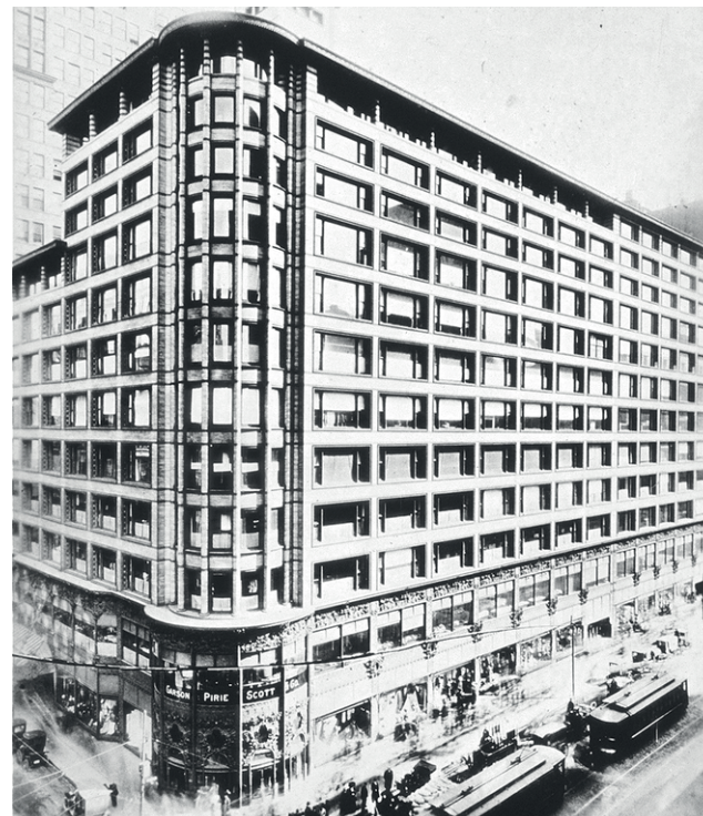
Imagen 3.31. Los almacenes después del añadido de Burnham.
