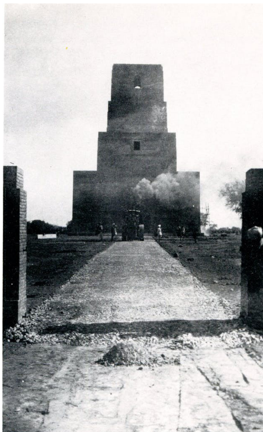
Fig. 4; Vista exterior de St Martin's Garrison Church durante su construcción. Shoosmith, 1930.
