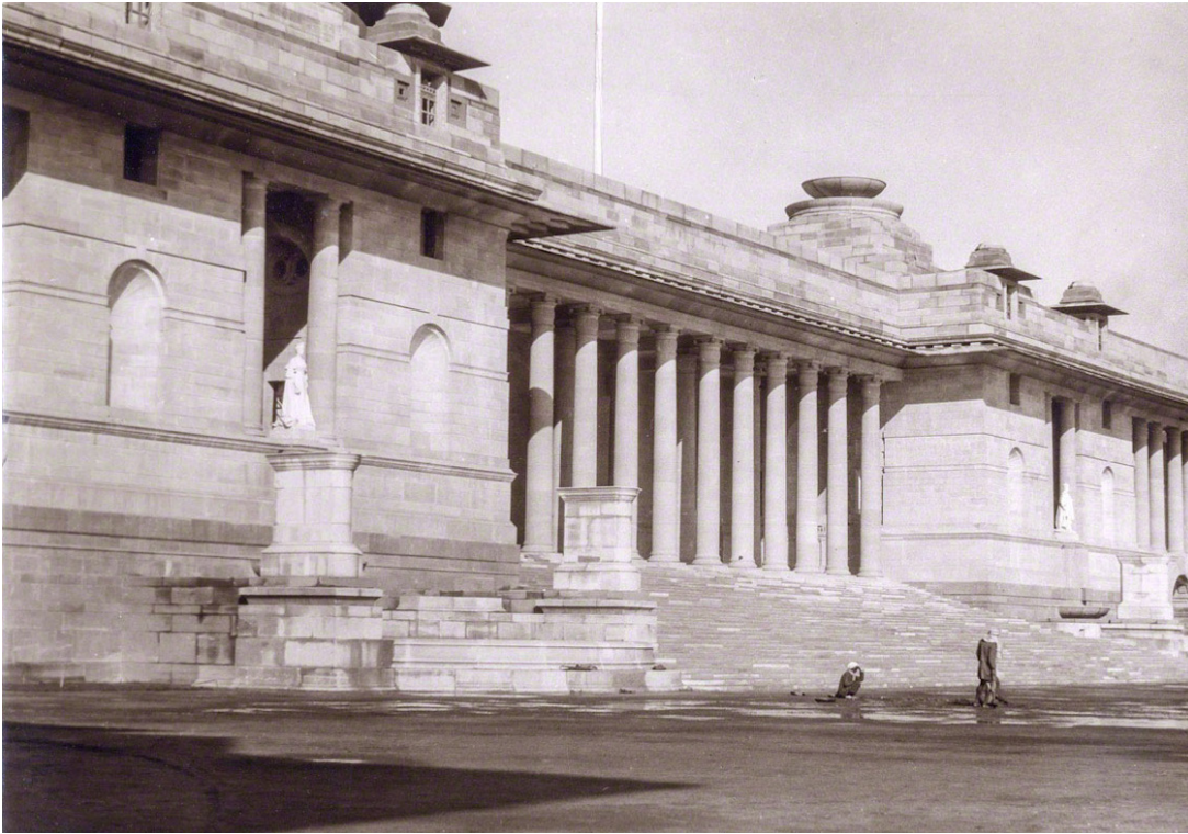
Fig. 18: Entrada frontal de la Casa del Virrey. Nótese el alero continuo de piedra que recorre la parte superior de la fachada; la columnata del orden creado por Lutyens para Delhi; las enormes fuentes que flanquean la escalinata desde lo alto del edificio; los pequeños grupos de Chattris ; y la ausencia de la gran cúpula, (aun por construir).
