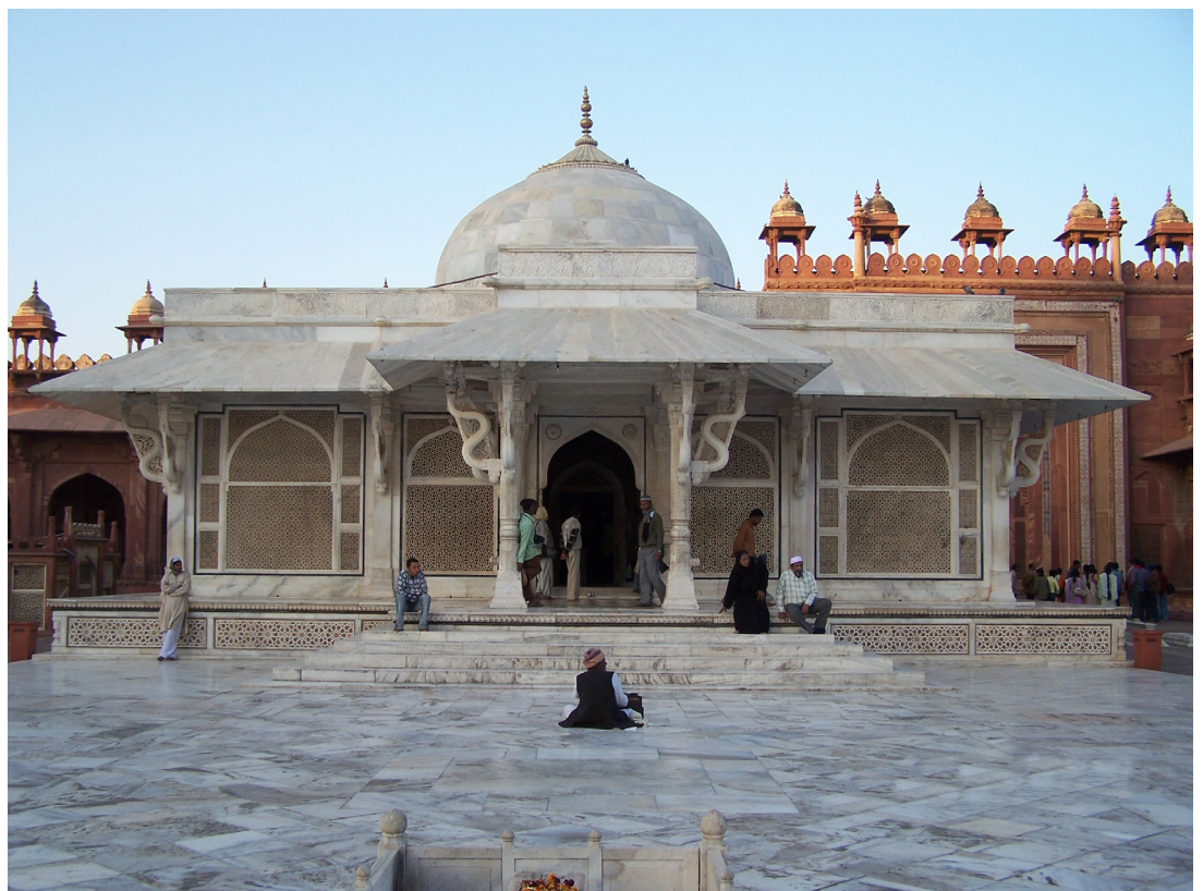
Fig. 17: Tumba de Salim Chisti en Fatehpur Sikri (1581), ejemplo de arquitectura mogola. Nótese el alero de piedra tallada que recorre el perímetro del edificio, denominado Chhajja .
