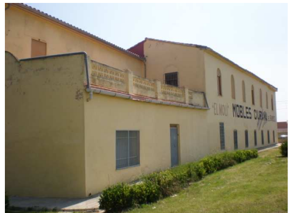
Fig. 6.50. Fachada lateral del molino y almacén
