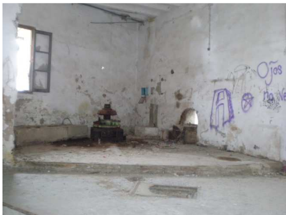
Fig. 6.42. Interior del molino
