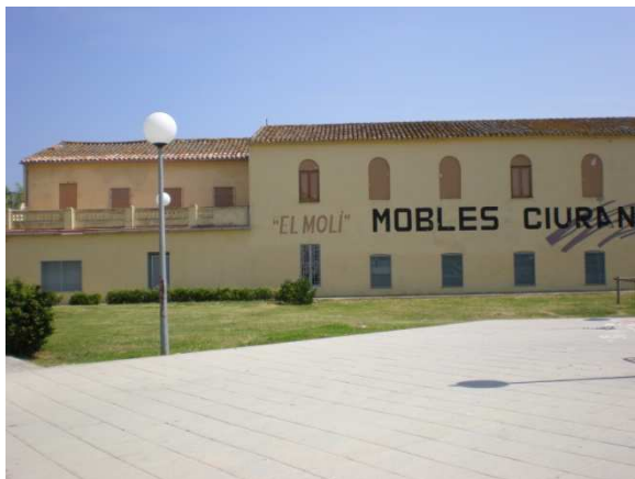
Fig. 6.49. Fachada lateral del molino y almacén
