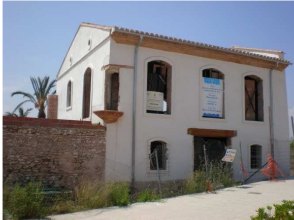
Fig. 6.93. Fachada principal del almacén
