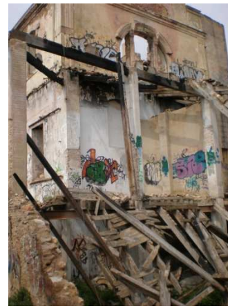
Fig. 6.6. Cuerpo central derruido por el incendio
