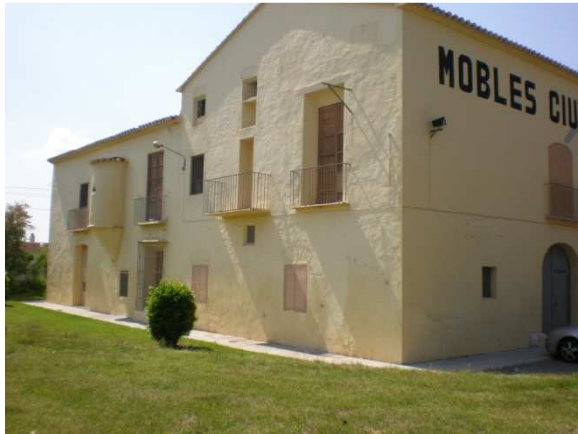
Fig. 6.53. Fachada lateral del la vivienda
