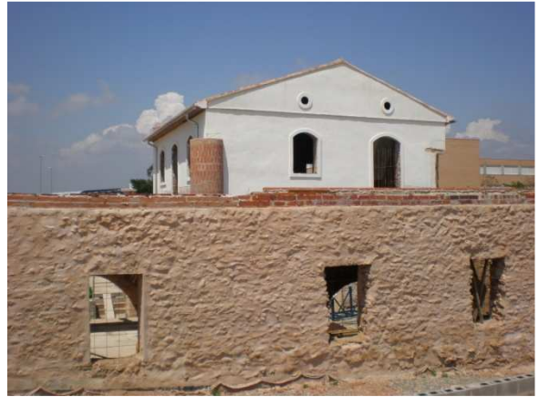
Fig. 6.100. Fachada lateral del conjunto
