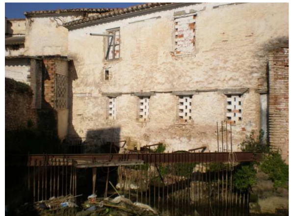
Fig. 6.30. Fachada posterior del molino
