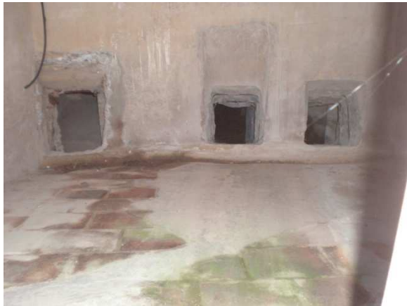
Fig. 6.76. Distribución de agua a las distintas muelas
