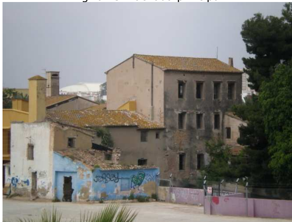
Fig. 6.15. Vista general de los molinos
