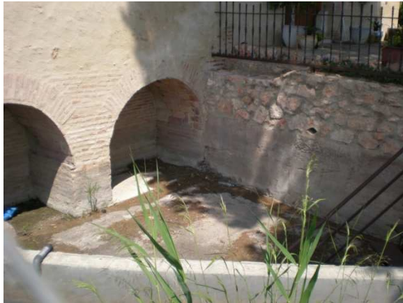
Fig. 6.85. Cárcavos de salida del agua
