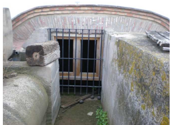
Fig. 6.75. Cárcavo de entrada del agua
