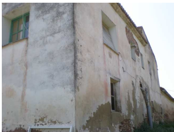
Fig. 6.79. Fachada lateral de la vivienda
