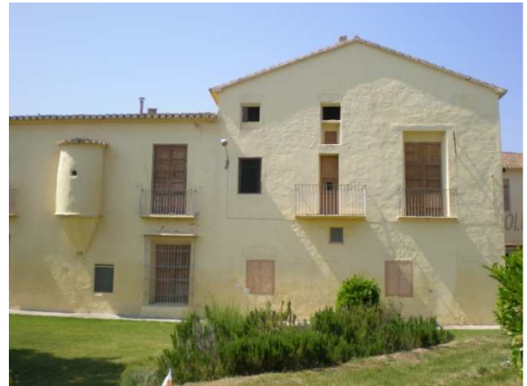
Fig. 6.54. Fachada lateral del vivienda
