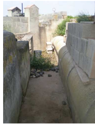
Fig. 6.77. Acequia de entrada del agua al molino
