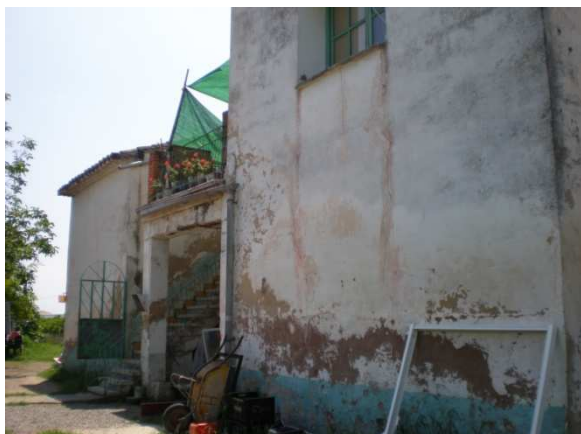
Fig. 6.80. Fachada principal de la vivienda
