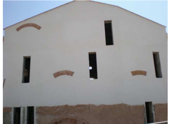
Fig. 6.94. Fachada lateral del almacén
