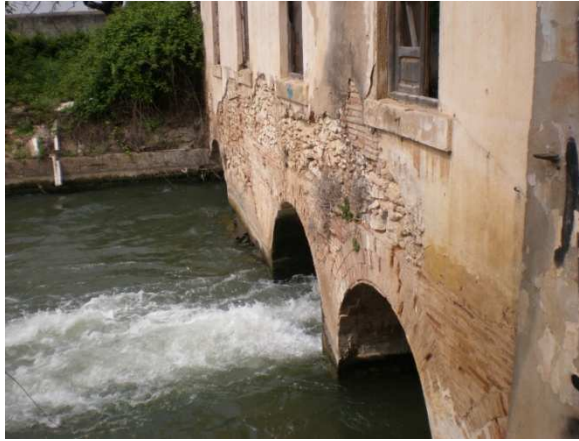
Fig. 6.9. Cárcavos del antiguo molino
