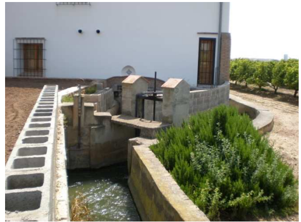
Fig. 6.72. Entrada del agua al molino
