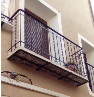
Figuras 55, 56 y 57. Balcones de fundición con pletinas dobladas de principios del siglo XX. En la figura 55 aparece la peculiaridad de la ornamentación floral
