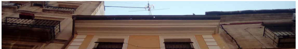
Figura 64. Alero formado con moldura
