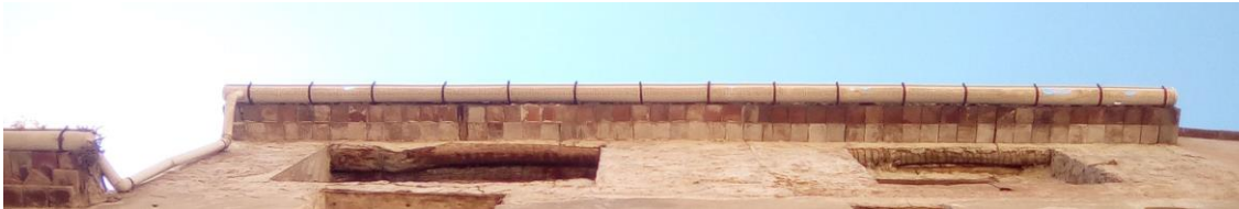
Figura 60. Alero con hilera simple de ladrillo a tizón
