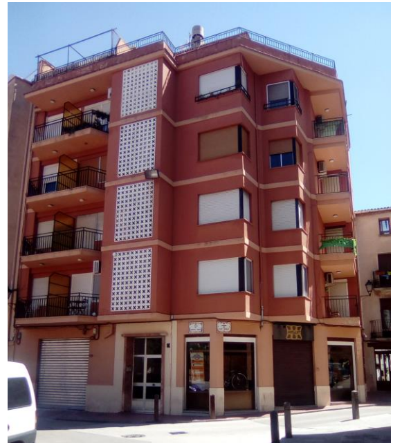
Figura 83. Vivienda situada en la plaza Cardenal Ferris
