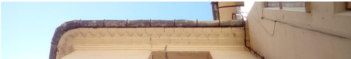
Figura 62. Alero de ladrillo con molduras decorativas
