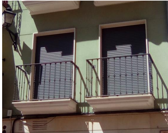
Figuras 112 y 113. Ejecución moderna de la cerrajería de las barandillas
