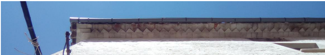
Figura 61. Alero de ladrillo en aparejo de pico de gorrión
