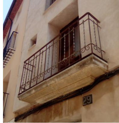
Figuras 55, 56 y 57. Balcones de fundición con pletinas dobladas de principios del siglo XX. En la figura 55 aparece la peculiaridad de la ornamentación floral
