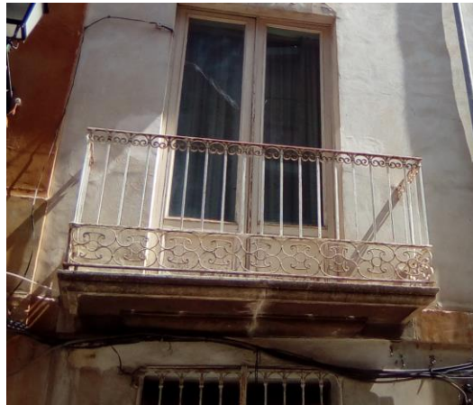
Figuras 51, 52, 53 y 54. Balcones de fundición con la barandilla y el voladizo separados de mediados del siglo XIX. En la primera figura se puede ver la inclusión de la sujeción en el centro del balcón mediante una riostra
