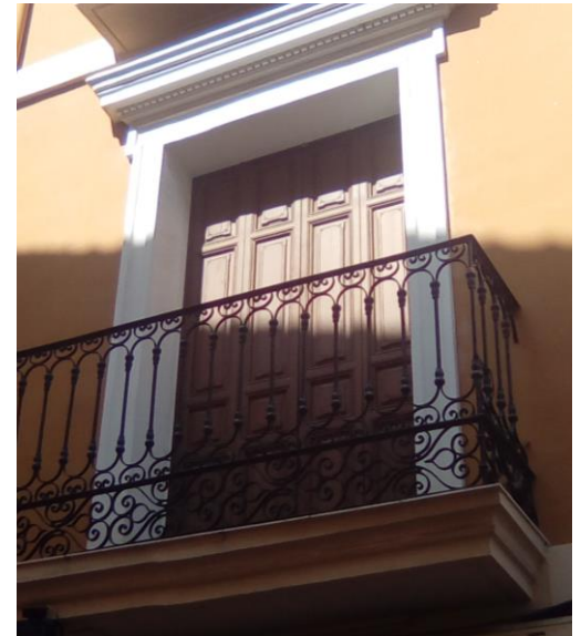
Figura 79. Carpintería de madera de cuatro piezas móviles.
