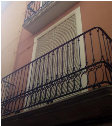
● Figura 95. Persiana alicantina colocada en la parte exterior del hueco
