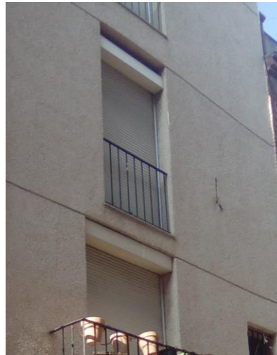
● Figura 96. Cajas de persiana colocadas en el exterior de la vivienda
