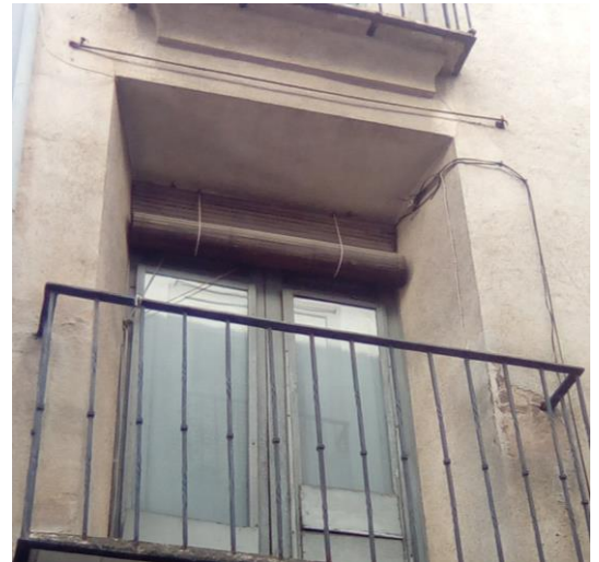
Figuras 67 y 68. Huecos donde las jambas y el dintel aparecen abocinados. Primera mitad del siglo XIX
