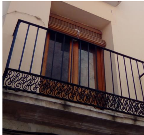
● Figuras 97 y 98. Persianas alicantinas instaladas de forma correcta
