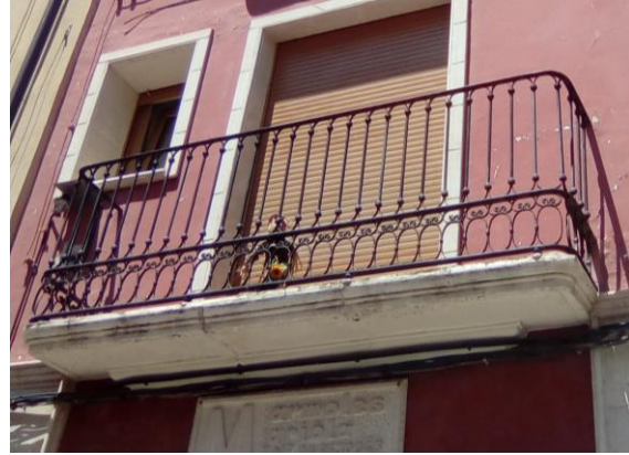
Figuras 51, 52, 53 y 54. Balcones de fundición con la barandilla y el voladizo separados de mediados del siglo XIX. En la primera figura se puede ver la inclusión de la sujeción en el centro del balcón mediante una riostra
