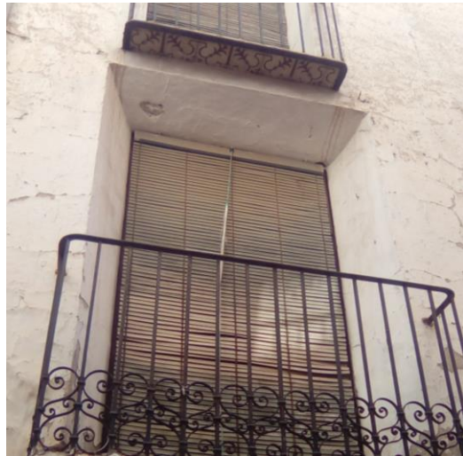
Figuras 67 y 68. Huecos donde las jambas y el dintel aparecen abocinados. Primera mitad del siglo XIX
