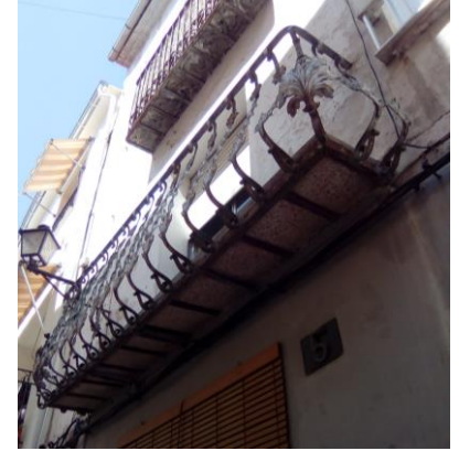
Figuras 55, 56 y 57. Balcones de fundición con pletinas dobladas de principios del siglo XX. En la figura 55 aparece la peculiaridad de la ornamentación floral
