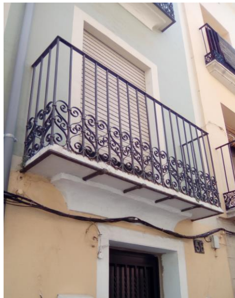
Figuras 48, 49 y 50. Balcones de forja en forma de jaula de principios del siglo XIX
