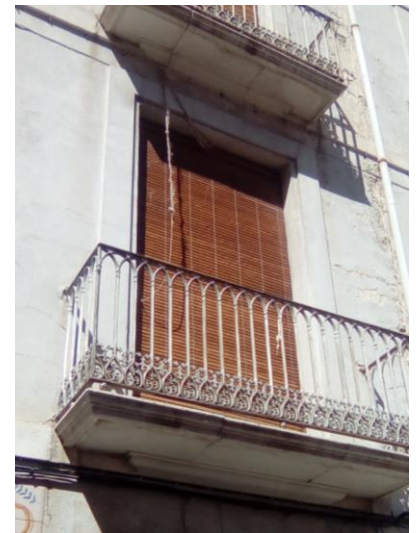
Figuras 67 y 68. Huecos donde las jambas y el dintel aparecen abocinados. Primera mitad del siglo XIX
