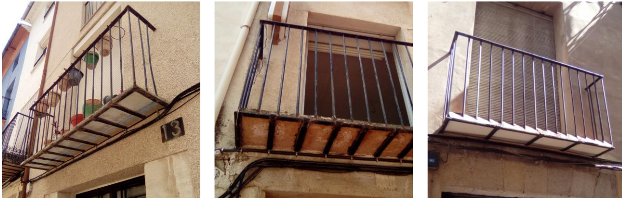
Figuras 43, 44 y 45. Balcones de forja en forma de jaula, tal vez de la primera mitad del siglo XVIII
