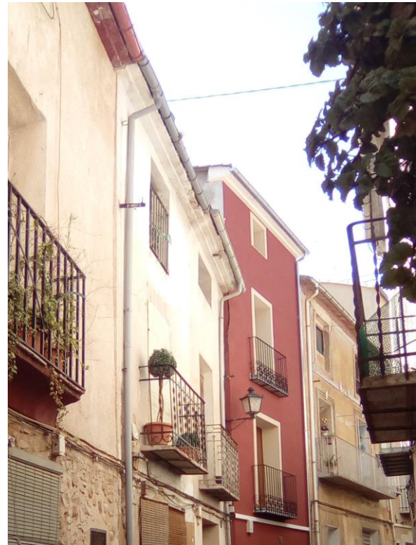
Figura 4. Vista de las fachadas de la calle Créixens
