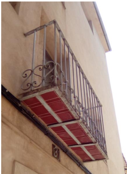
Figuras 48, 49 y 50. Balcones de forja en forma de jaula de principios del siglo XIX
