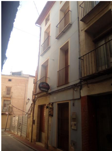
Figura 39. Vivienda con dos columnas de huecos
