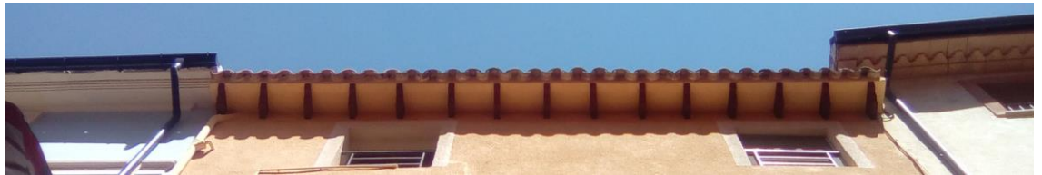
Figura 63. Alero con viguetas de madera
