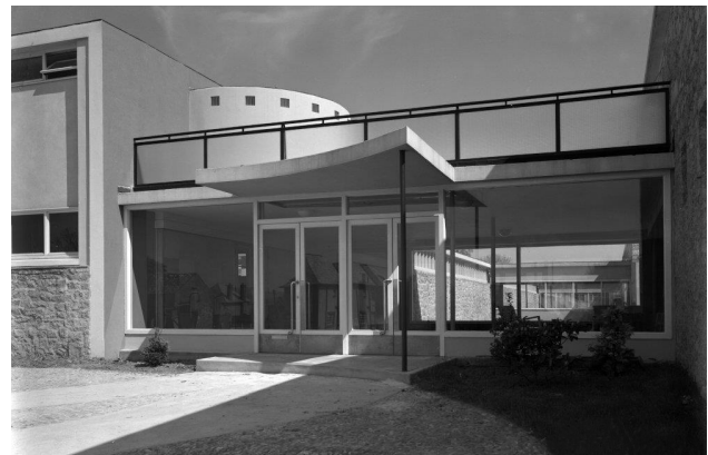
Figura 11. Entrada principal, Girls High School , Richmond. Edificio construido entre 1939-1940.
