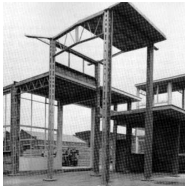
Figura 17. Modelo experimental del sistema 8'3" en la fábrica de Hills & Co.
