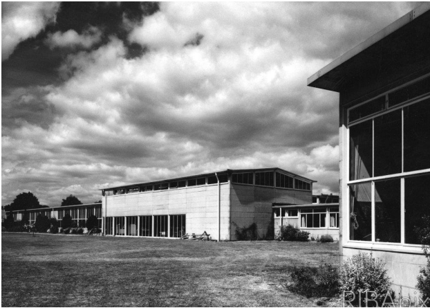
Figura 24. Hall, Burleigh Primary School , Cheshunt. Edificio construido en 1948.
