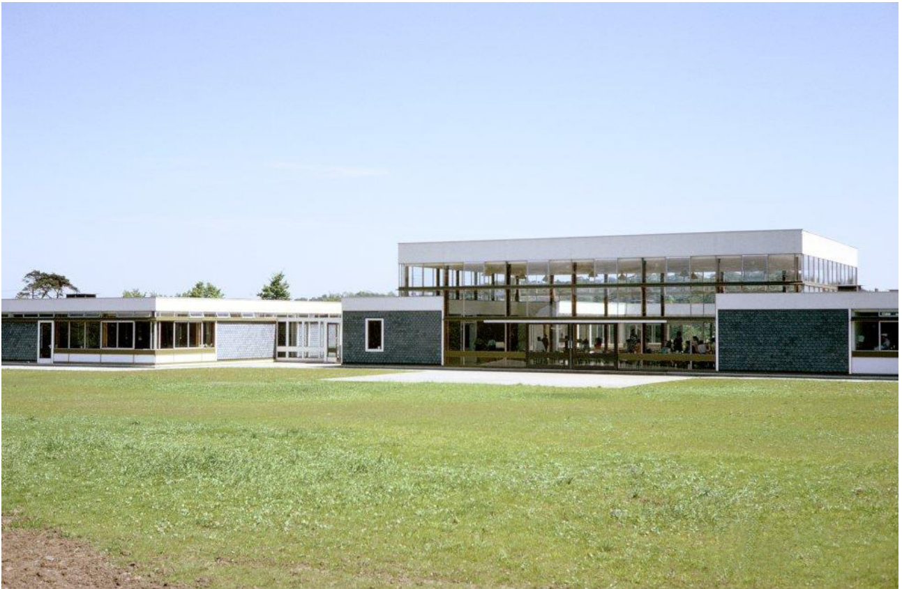
Figura 33. St. Leonards School, en Bridgnorth, construida con el sistema SCOLA en 1960.
