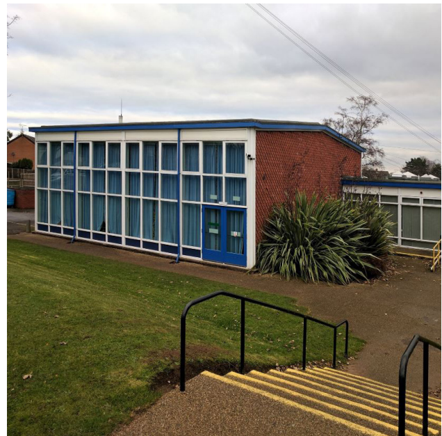
Figura 30. Intake Farm School , Mansfield. Edificio construido entre 1956-1957.
