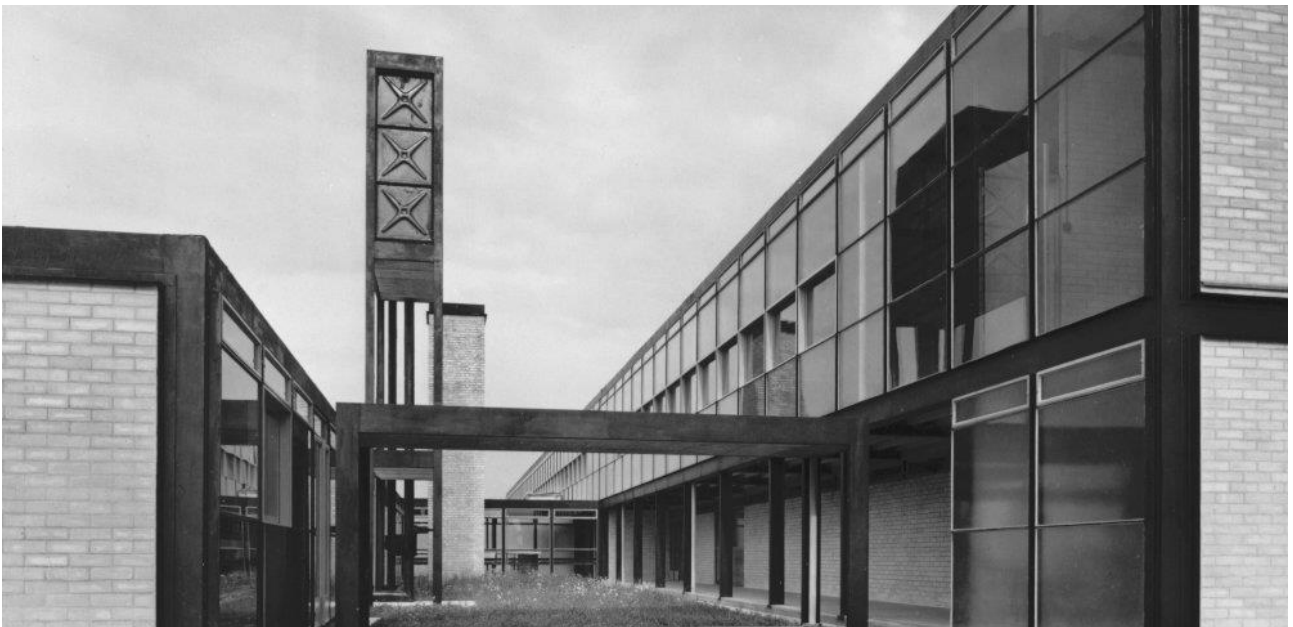
Figura 38 (inf.) Patio de la cocina, torre de agua y la chimenea, Hunstanton Secondary Modern School, Hustanton, Norfolk. Edificio construido en 1954.
