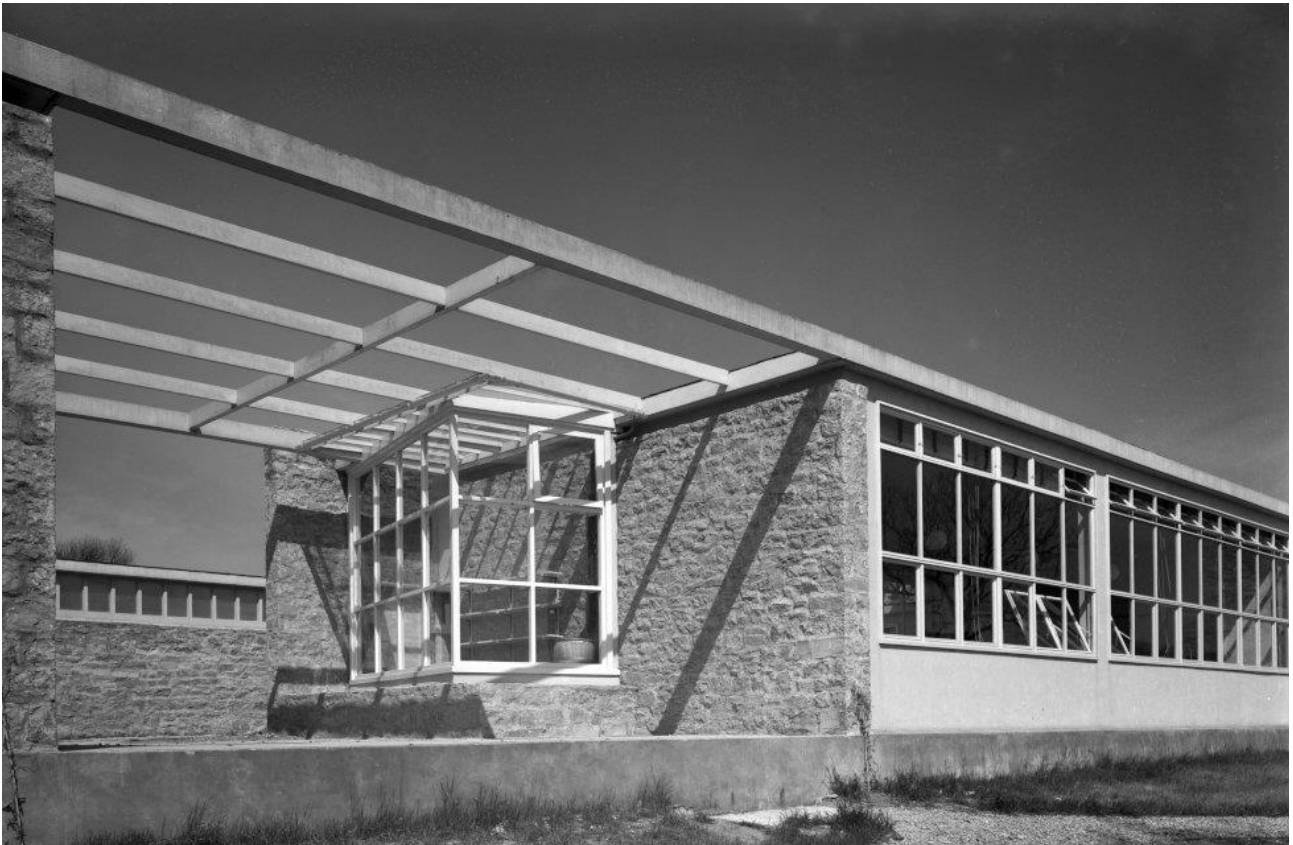
Figura 12. Aulas, Girls High School , Richmond. Edificio construido entre 1939 -1940.
