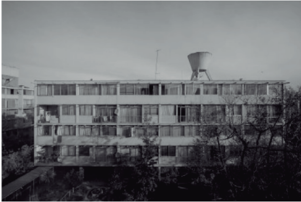
Figura .48. Fotografía de la fachada norte del bloque C.
