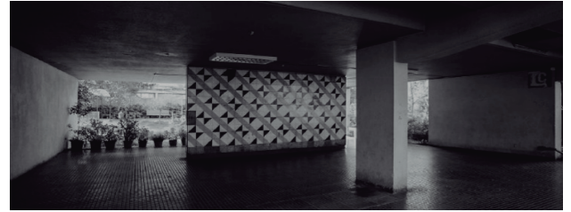
Figura .37. Muros revestidos con baldosas geométricas.
