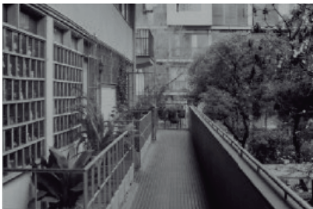
Figura .36. Imágen de las calles de los bloques B-C-D.
