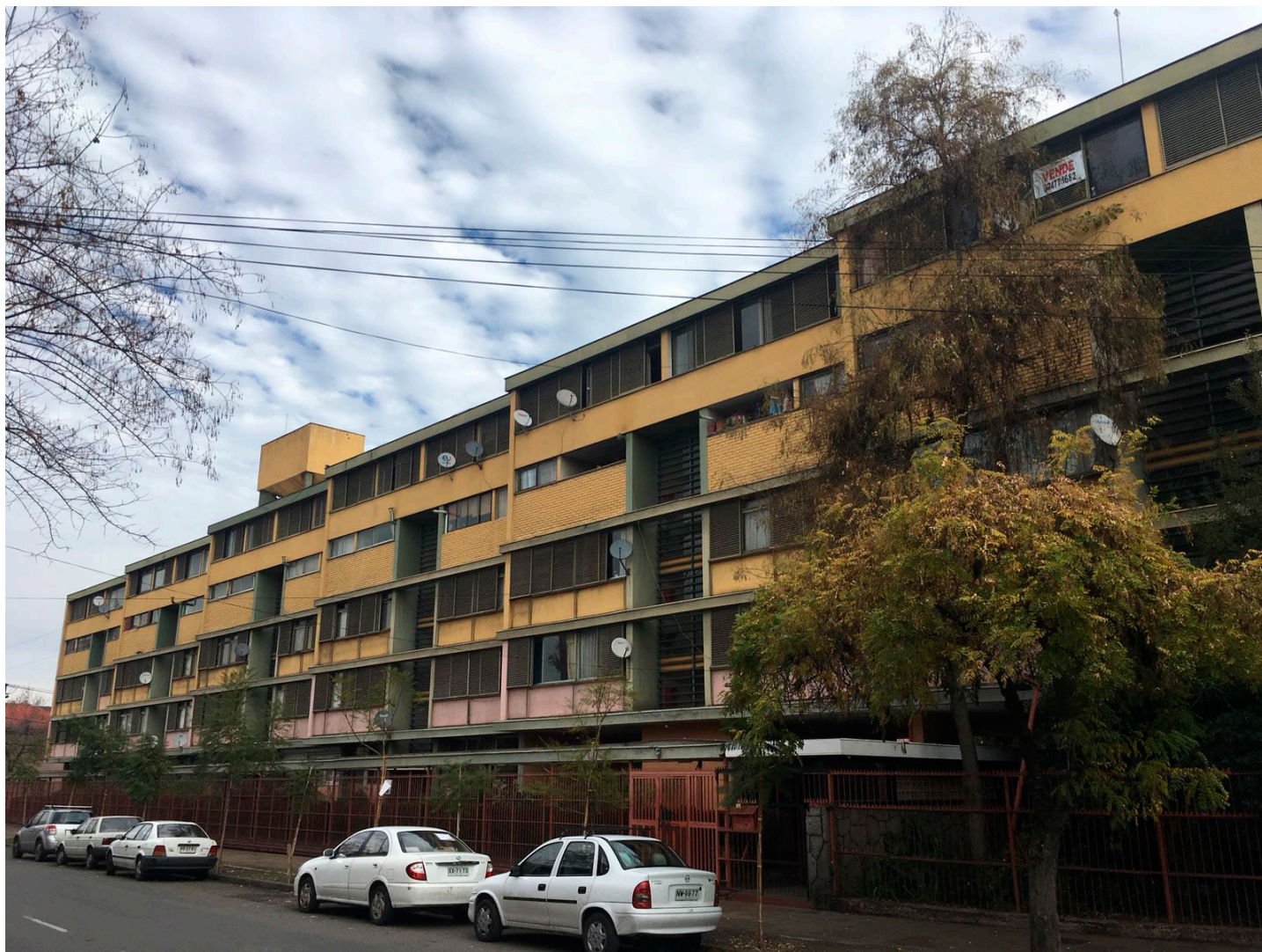
Fig.5. Fotografía de la fachada con retranqueos desde la calle San Ignacio.
