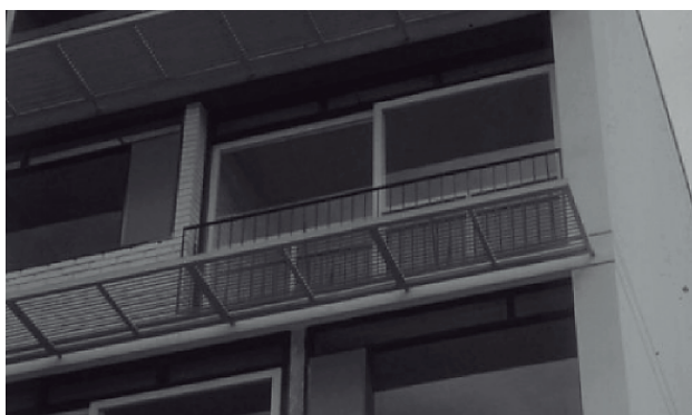
Figura .35. Imágen de la fachada norte de los bloques B-C-D.
