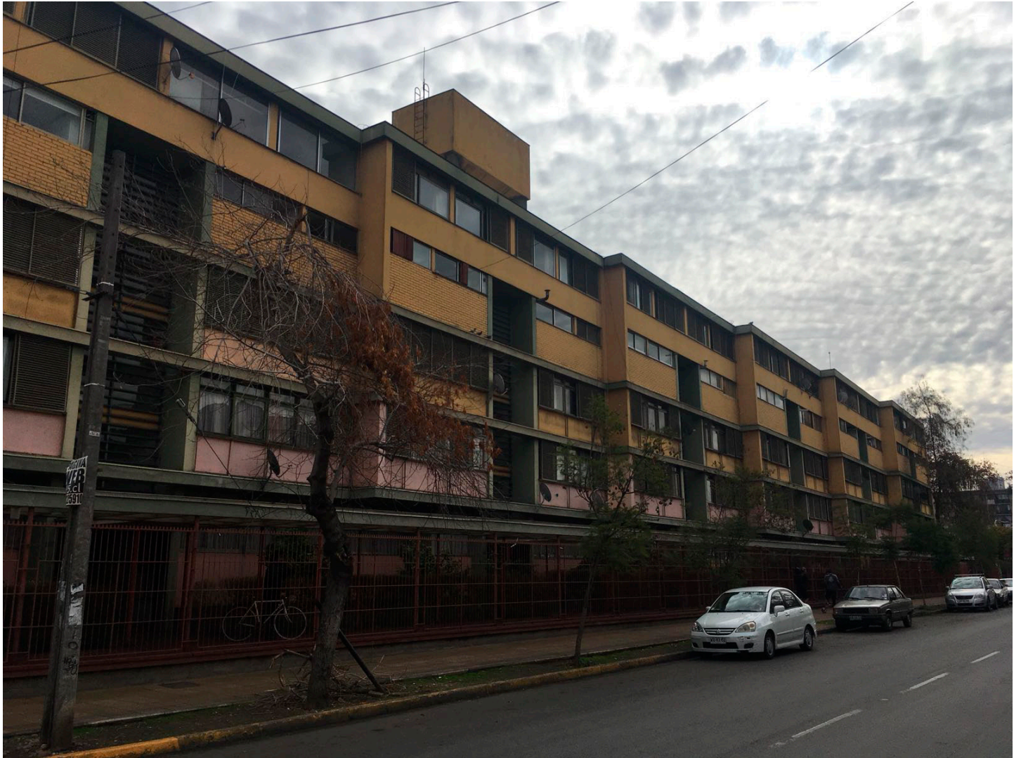
Figura.4. Fotografía de la fachada con retranqueos desde la calle San Ignacio.
