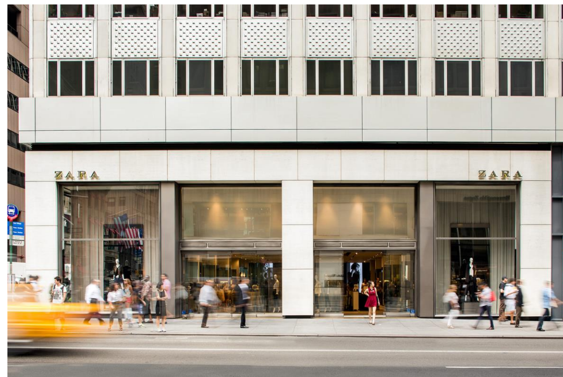
FIGURA 34. Fotografía. Zara Quinta Avenida de Nueva York – NYC.com
