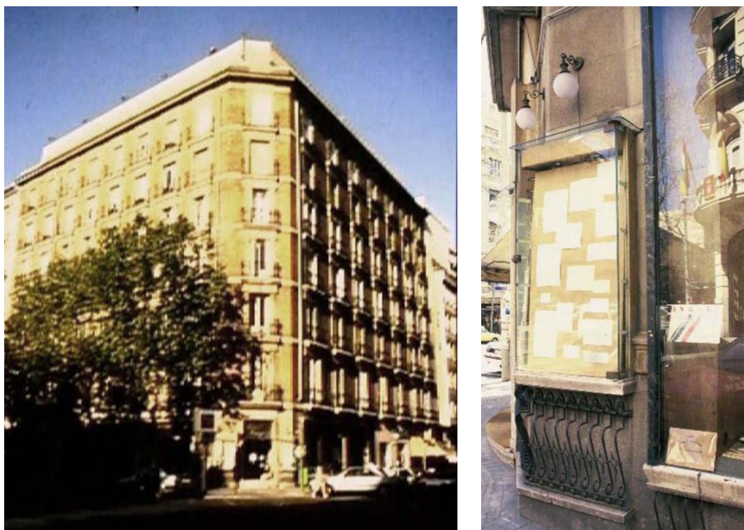
FIGURA 56 Fotografías fachada original Zara Serrano año 1950 – Archivo Ayuntamiento Madrid
