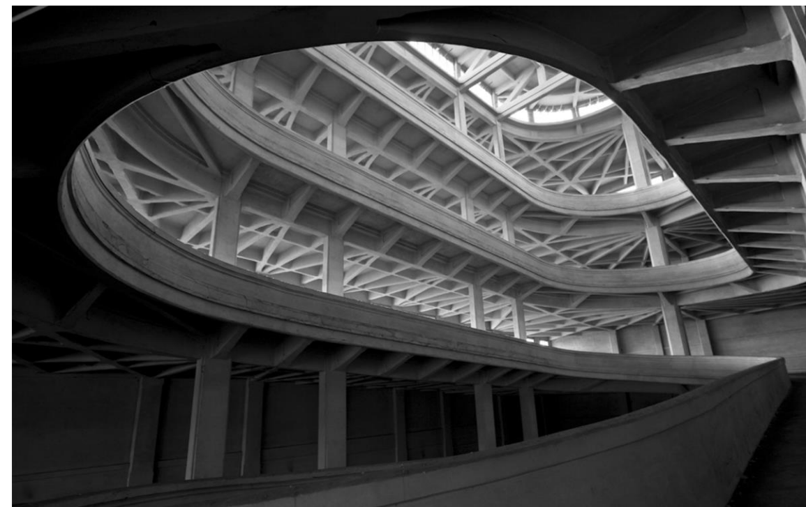
FIGURA 25. Fotografía. Estructura de hormigón Edificio Lingotto fábrica Fiat - Giacomo Mattè Truco
