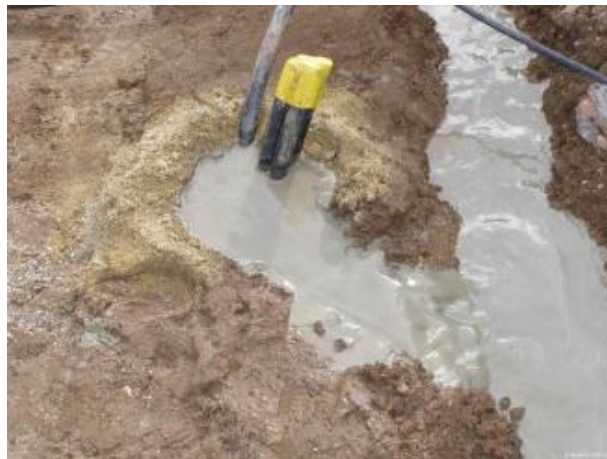
Figura 10: Cementación del sondeo geotérmico
