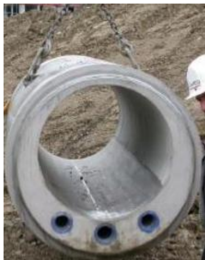
Figura 12: Aprovechamiento de la energía de la red de saneamiento urbano para la climatización de edificios
