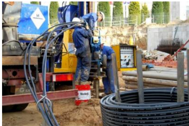
Figura 9: Colocación de sondas geotérmicas
