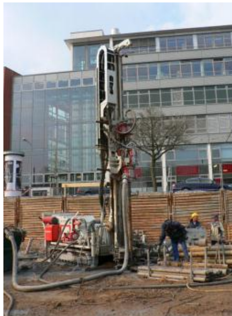
Figura 8: Perforadora con doble unidad de rotación y manguera para descarga de detritos en un contenedor
