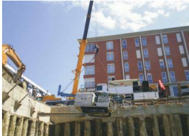
Figura 7: Descenso de una perforadora a una excavación
