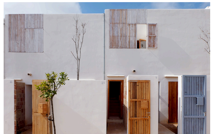
Figura 5.16 Fachada de acceso
