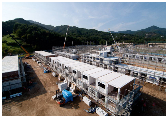
Figura 5.10 Construcción de los bloques
