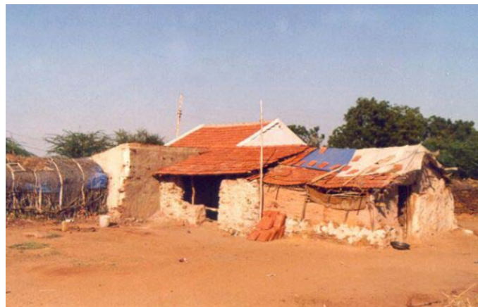
Figura 3.7 Híbrido de estructuras en Gujarat
