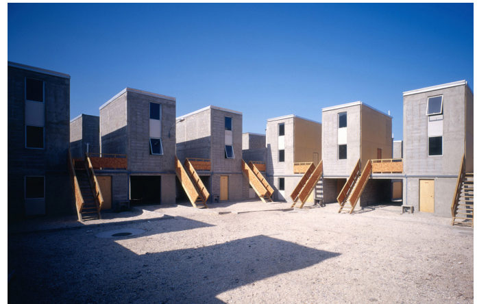
Figura 5.20 Bloques recién terminados
