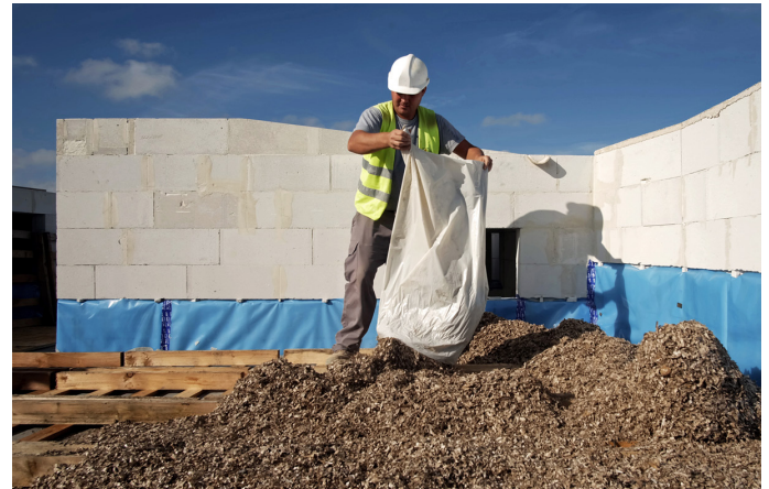
Figura 5.17 Proceso de relleno con posidonia
