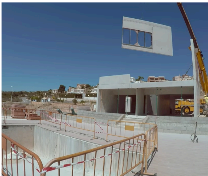
Figura 5.4 Montaje de una vivienda Ubiko
