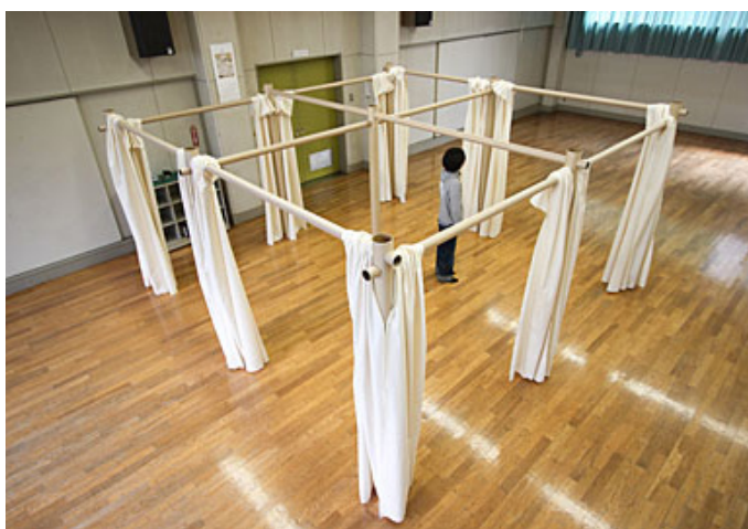
Figura 2.5 Módulo construido del Paper Partition System 4
