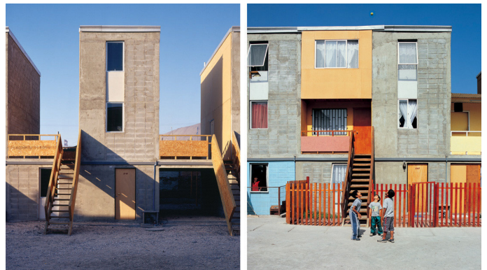
Figura 5.21 Contraste con el añadido autoconstruido
