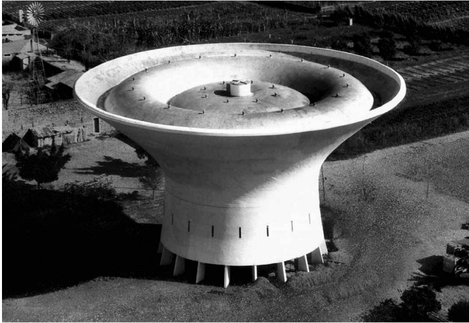
Imagen 4: Vista exterior de la Cuba de Fedala, Torroja, 1956. (Fuente: Revista Ingeniería y Territorio, nº 79, 2007)
