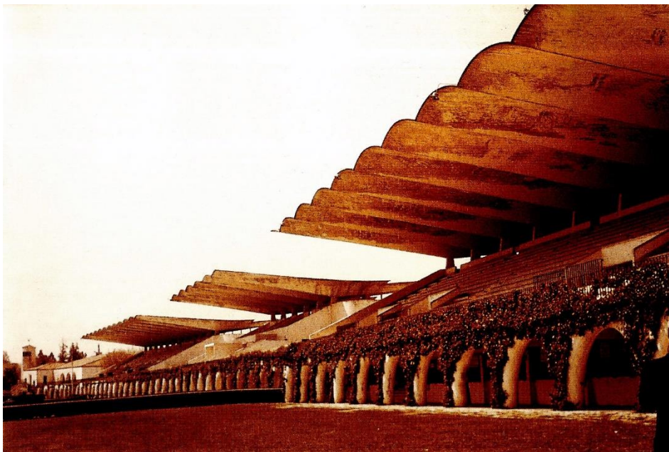
Imagen 16: Vista desde la pista del conjunto de tribunas (Fuente: Libro “Las Estructuras de Eduardo Torroja”, 1999)
