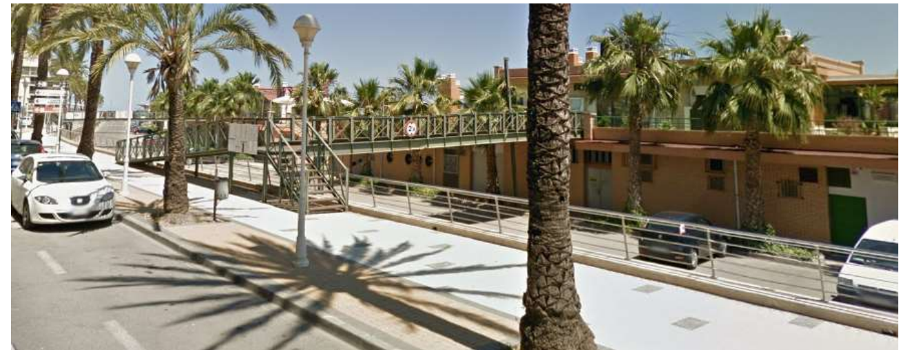
Ilustración 38. Edificaciones con efecto barrera física y visual
