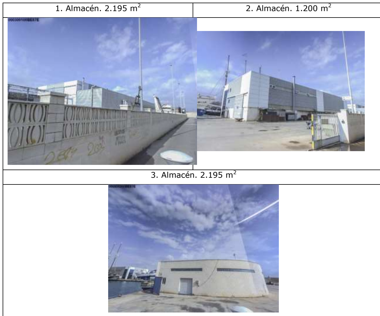
Ilustración 32. Fotografías de las instalaciones que componen la zona de varadero
