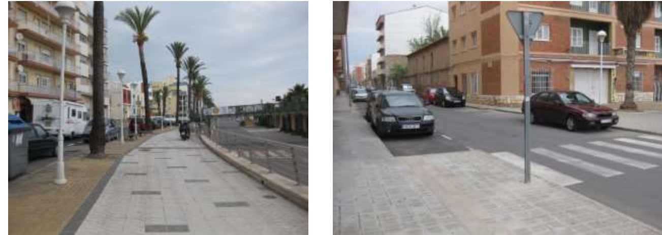
Ilustración 46. Imágenes del estado actual de la Avenida Marqués de Benicarló
