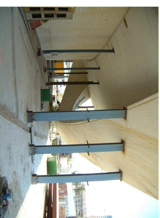
Figura 15. Vista del balancín con apoyos provisionales.
