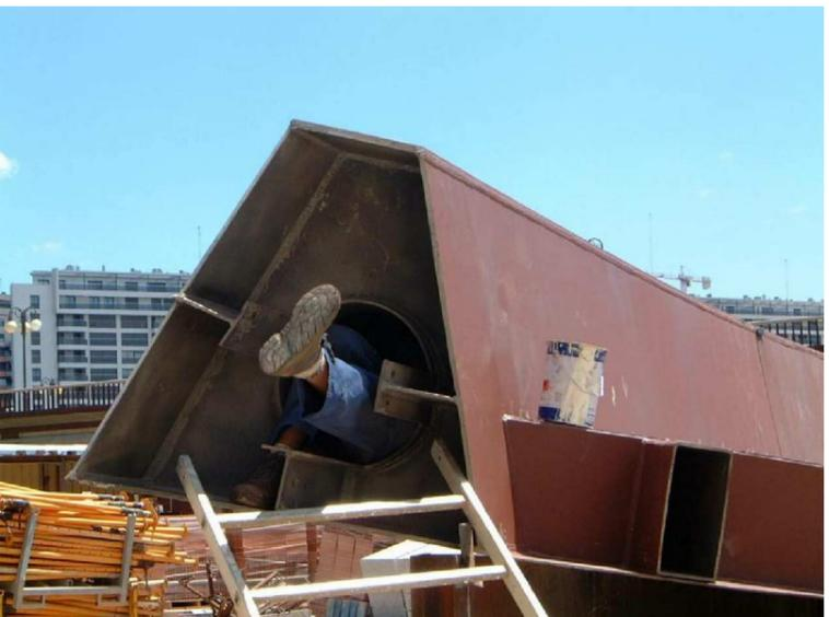
Figura 10. Viga de borde inferior
