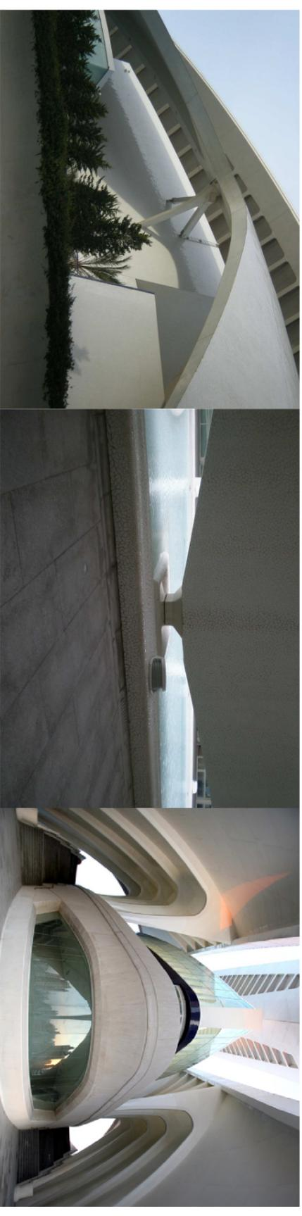
Figura 8. Fotografías de los apoyos definitivos de la cáscara. De izquierda a derecha, pieza clave sobre trípode, balancín sobre rótula y arbotantes apoyados en el pórtico principal.
