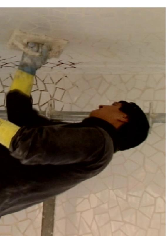
Figura 67, 68, 69, 70 y 71. Imágenes de la aplicación del adhesivo Superflex y de la colocación de las mallas de trencaadís. En la última imagen se aprecia la diferencia de tonalidad y brillo que adquiere el revestimiento al aplicar el rejuntable con el sistema Fugabella 2-12.
