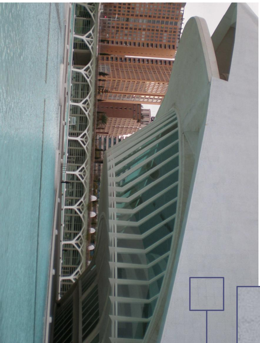
Figura 62. Fotografía de la cáscara y detalle de una zona en la misma donde se aprecia el "efecto damero", identificándose claramente la disposición de las distintas mallas y las juntas entre ellas.
