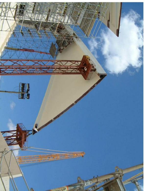
Figura 30. Fotografía durante la colocación de la pieza clave en obra.
