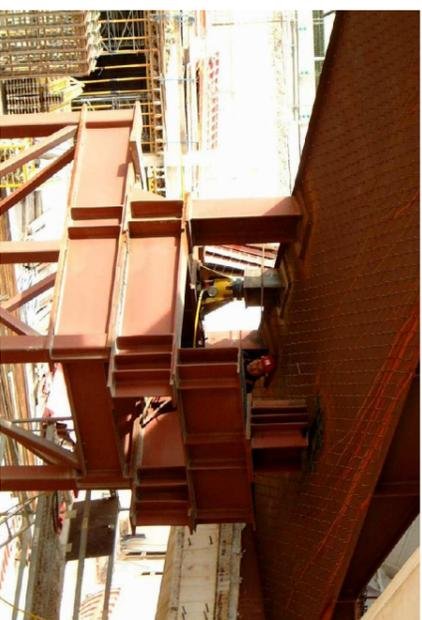
Figura 25, 26 y 27. Encima de estas líneas, imágenes de los apeos utilizados para el montaje de la cáscara, con sus correspondientes gatos hidráulicos para el control del descenso simultáneo de la cáscara. A la derecha, plano de los apeos introducido en el modelo de cálculo.
