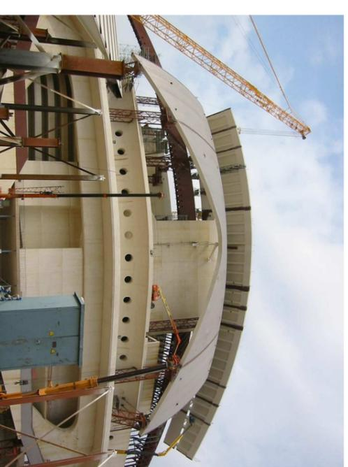
Figura 20. Imagen de la cáscara en fase de montaje. Se aprecia la unión entre el trípode y la pieza clave del sándwich.
