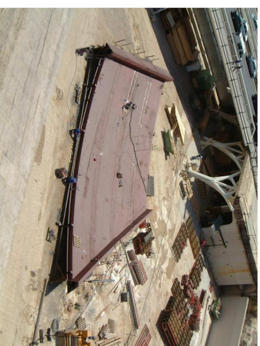
Figura 5. Vista del conjunto de sándwich (pieza de sándwich 3 según croquis de la figura 3) y de las vigas de borde superior e inferior antes de ser izada.
