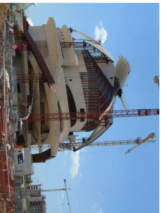
Figura 34. Fotografía de la obra correspondiente a la fase 2 de montaje de la cáscara
