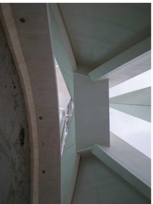
Figura 7. Viga en cajón en el extremo este, conectando ambas hojas de la cáscara. También se aprecian las vigas de borde que acometen en la punta.
