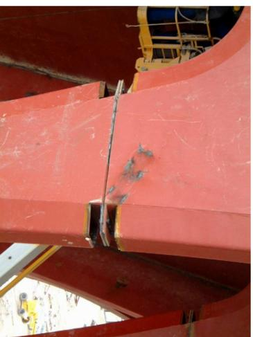
Figura 44 y 45. A la izquierda, unión atornillada entre distintas piezas que componen el arbotante. A la derecha, colocación del segundo arbotante y su correspondiente panel en obra.
