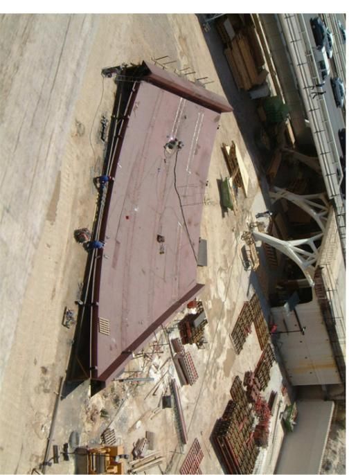
Figura 2. Vista de conjunto de sándwich y de las vigas de borde antes de ser izada.
