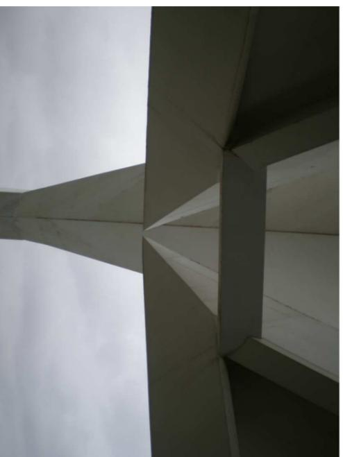
Figura 8. Viga de cajón en el extremo oeste.
