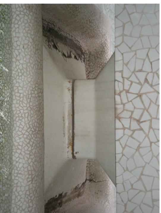
Figura 14. Detalle de la rótula, con una pieza superior y otra inferior.
