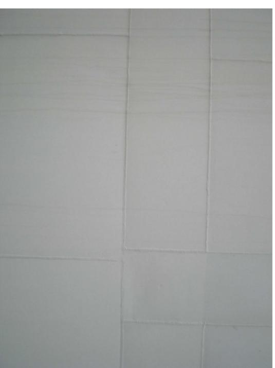
Figura 4. Fotografía de la hoja interior del sándwich conformada por pequeñas chapas unidas mediante soldadura.
