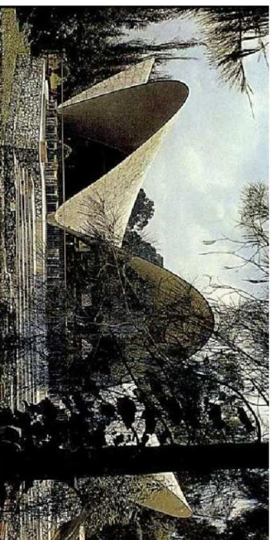
Figura 2. Restaurante Los Manantiales en Xochimilco construido por Félix Candela con una cubierta formada por la intersección de cuatro paraboloides hiperbólicos.
