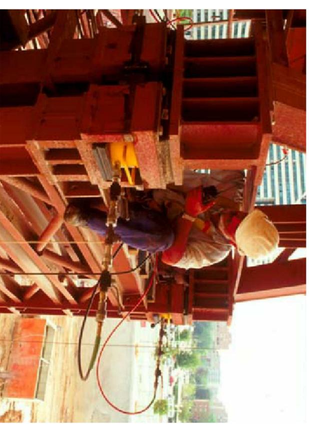
Figura 9. Fotografía de un operario sobre un castillete provisional provisto de un gato hidráulico.
