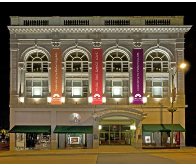
Fig 140. Fachada por la noche
