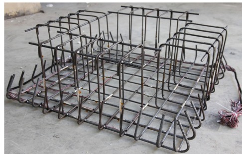
Armado de los encepados 3P-N-A3 y 4P-B3 FUENTE: Elaboración propia
