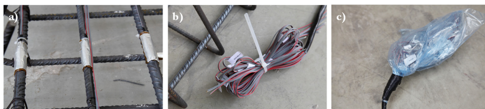
Figura 3.9 Detalles de la instrumentación del armado a) Protección de las galgas con ABM75 de HBM; b) Mazo de cables de galgas con el correspondiente etiquetado; c) Embolsado de cables para su protección durante el hormigonado
