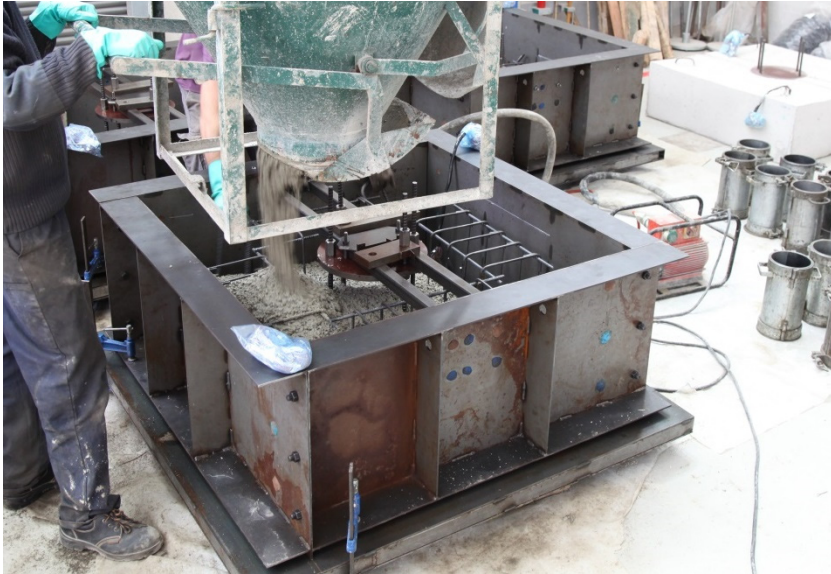
Figura 3.13 Vertido del hormigón en los encofrados
