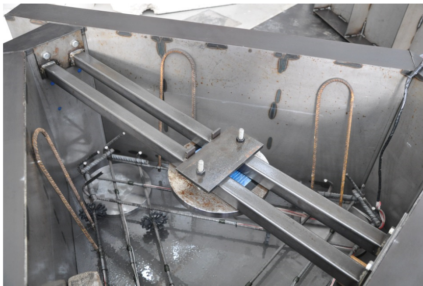
Figura 3.12 Perfiles tubulares que sujetan la placa de carga embebida a la que se atornilla el pilar metálico.
