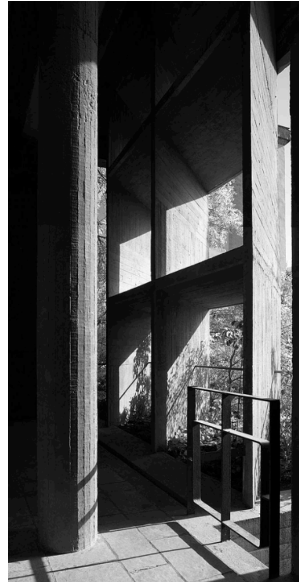
Figura 23. Foto brise-soleil inclinado fachada oeste.
