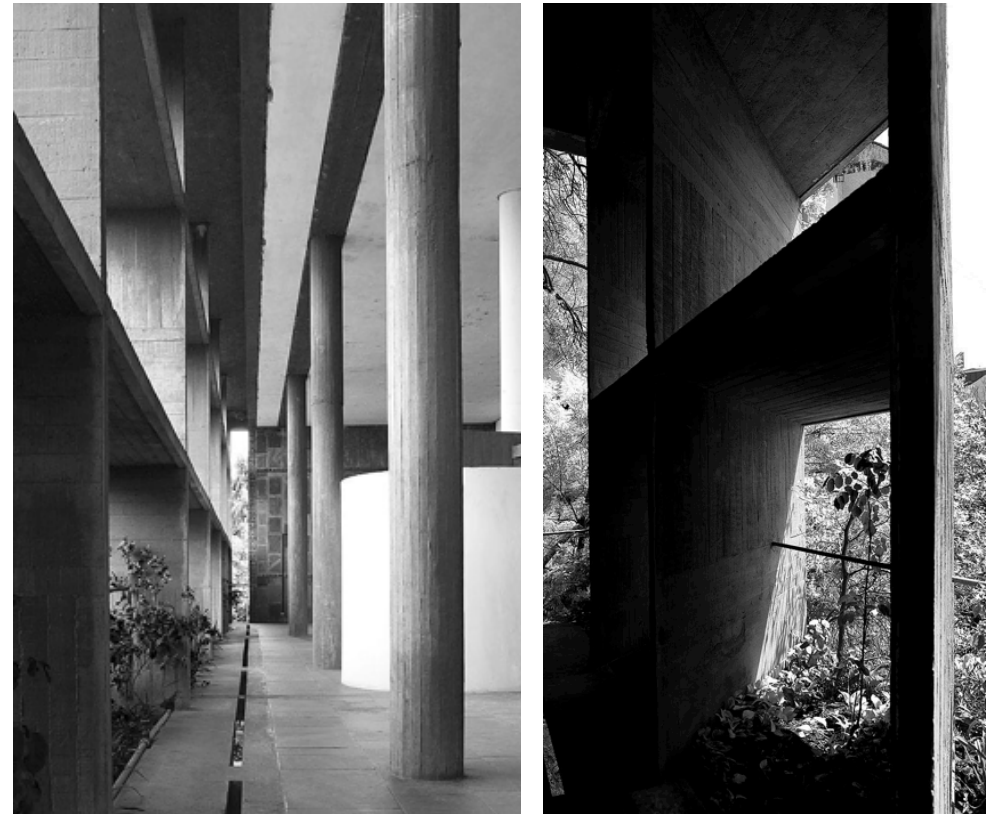
Figura 27 y 28. Fotografías brise-soleil fachada este y jardineras en el brise-soleil de la fachada oeste.
