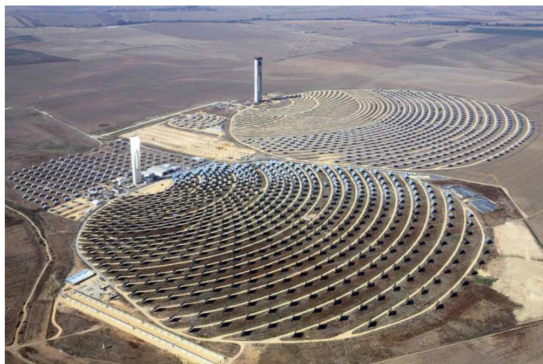
Figura 8: Central solar térmica PS20 y PS10 en Sevilla. Fuente: Abengoa Solar
