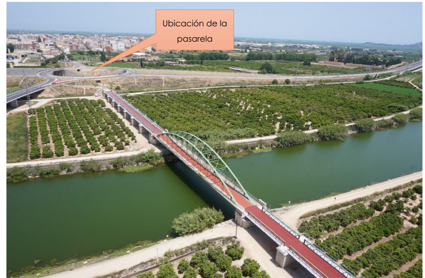
Figura 2 Puente de Alfonso XIII después de la rehabilitación. Fuente: Dron PAVASAL
