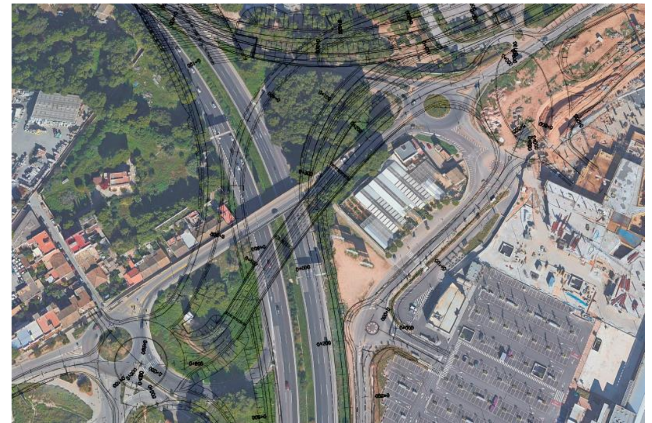
Figura 2. Paso superior sobre la Autopista de Llevant (Ma-19)
