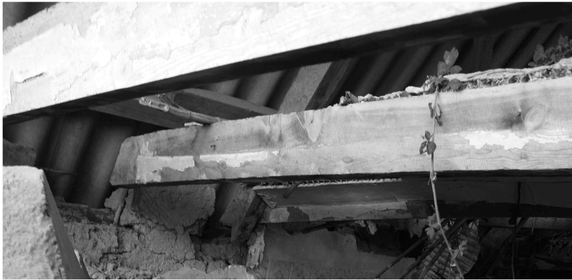
[Fig.31] Imagen desconexión tirantes. Fuente: Cristina Ramos Furió
