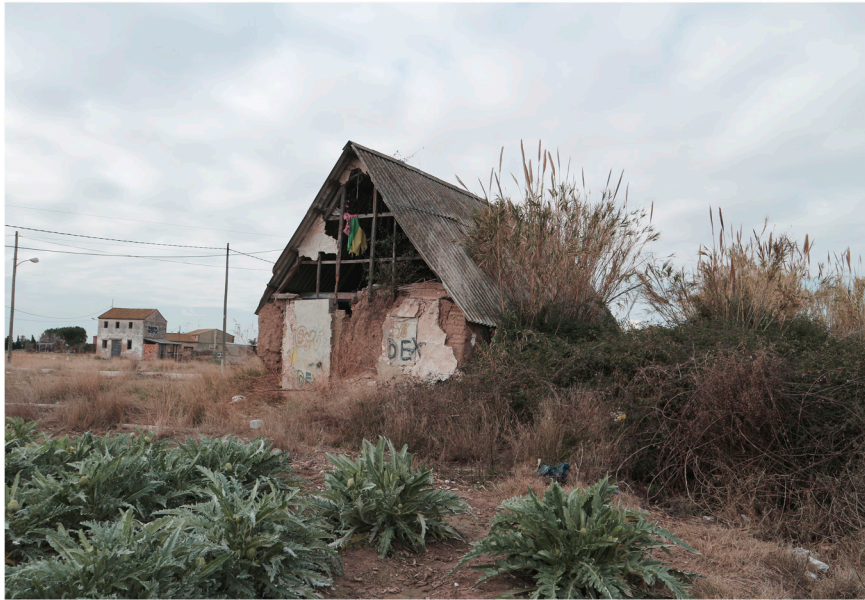
estado inicial trabajo
