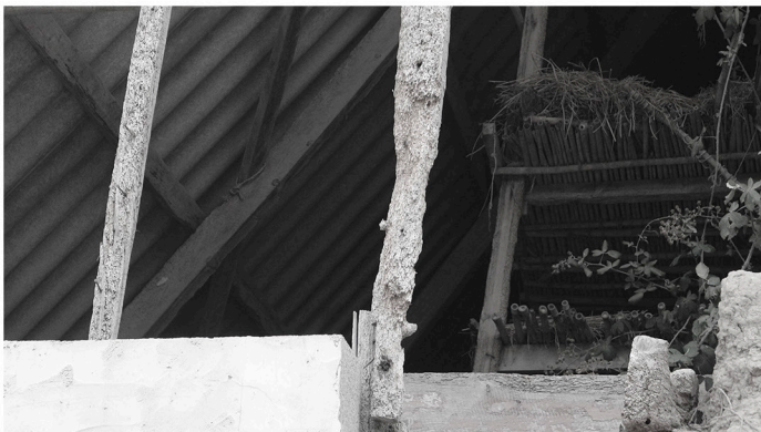
[Fig.40] Pudrición madera hastiales. Fuente: Cristina Ramos Furió
