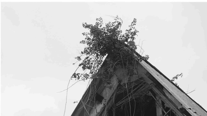
[Fig.39] Presencia vegetación en cubierta. Fuente: Cristina Ramos Furió
