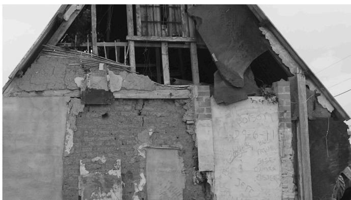
[Fig.37] Elementos impropios en el alzado oeste. Fuente: Cristina Ramos Furió
