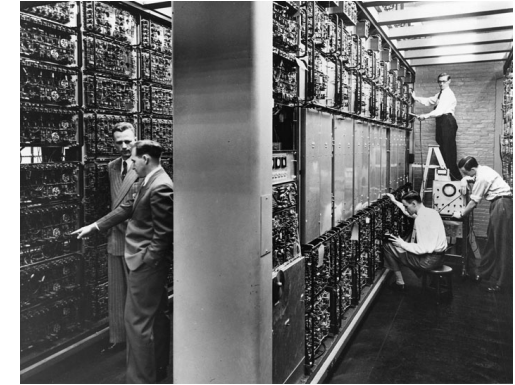
Figura_2.2. Forrester y Norman Taylor inspeccionando el circuito completo (1952).
