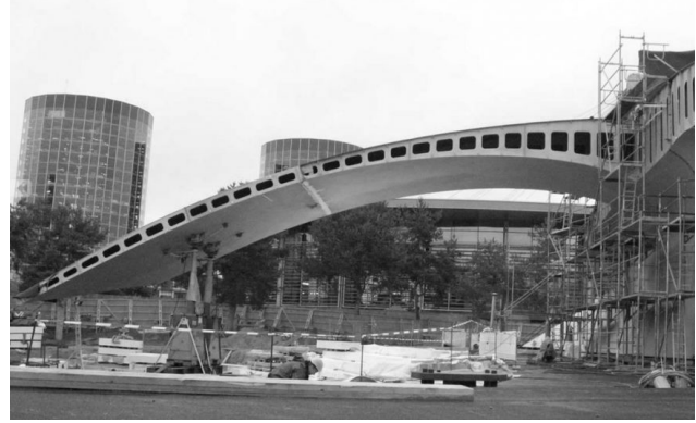
Imagen 35. Perspectiva del voladizo en construcción
