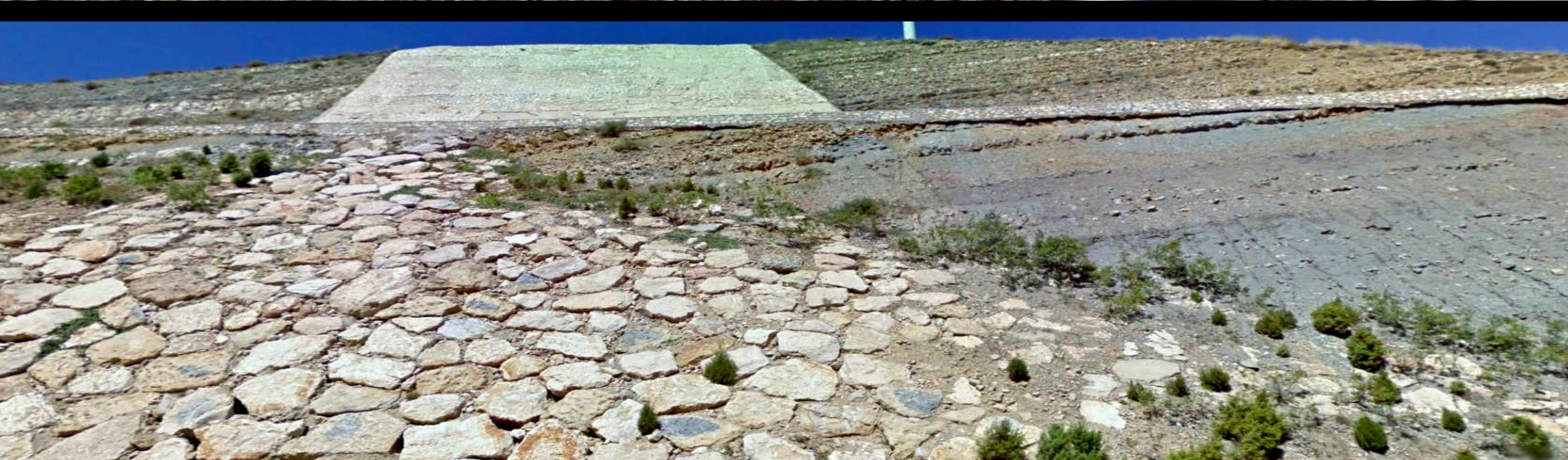
Actuaciones para la estabilización de taludes. En las calizas, margas y areniscas del Barremiense, Cretácico Inf. cerca del barranco de Gerona. NW NW del caserío de Torre Miró. Centro S Hoja de Peñarroya de Tastavins
