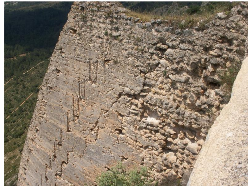
Fotografía 29: Muro interceptor (Se distinguen las líneas de los cajones y las agujas)
