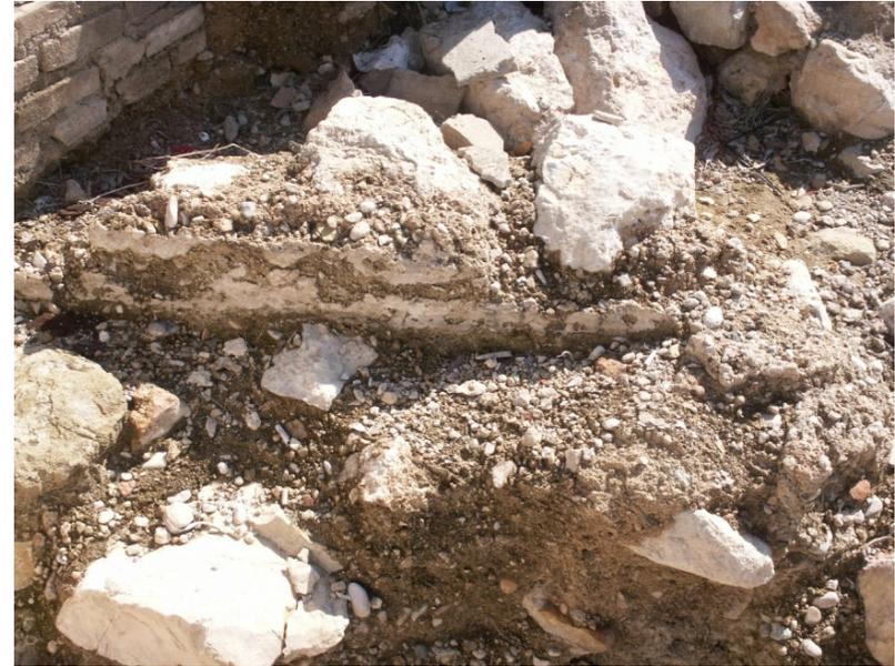
Fotografía 2: Excavación realizada recientemente en la que se puede ver el tapial con su revestimiento
