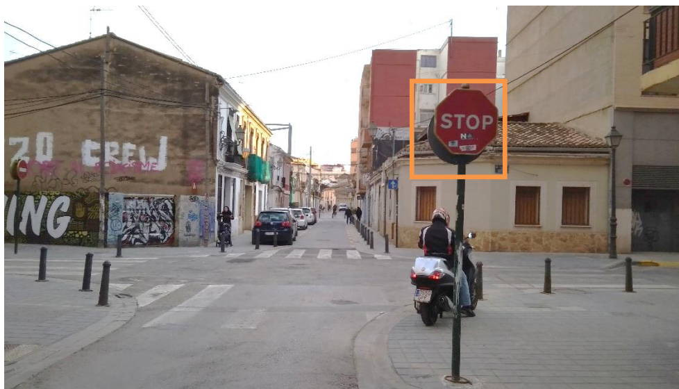
Figura 59: Señalización con evidencia de vandalismo o signos que pueden causar anomalías al momento de interacción con los vehículos AV.
