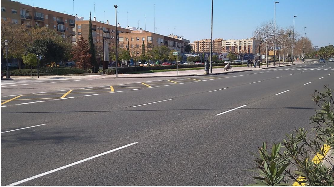
Figura 41: Tramo A11, Carriles medidos en la vía.
