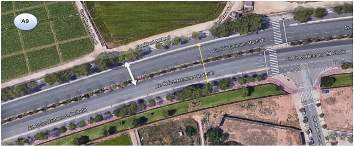
Figura 37: Tramo A9: Sección Germans Machado (c).
