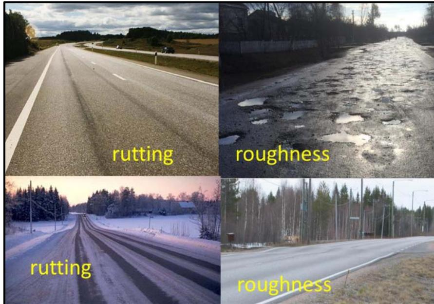
Figura 74. Afecciones del pavimento. Fte. RoadScanners
