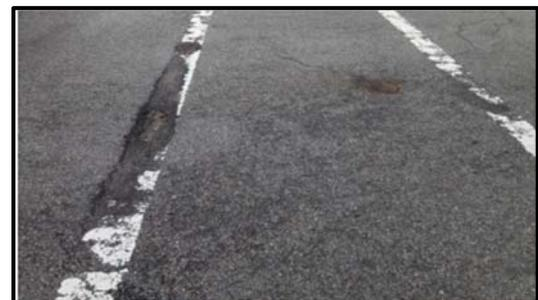
Figura 38. Marcas viales en deterioro. Fte. Toma Propia.
