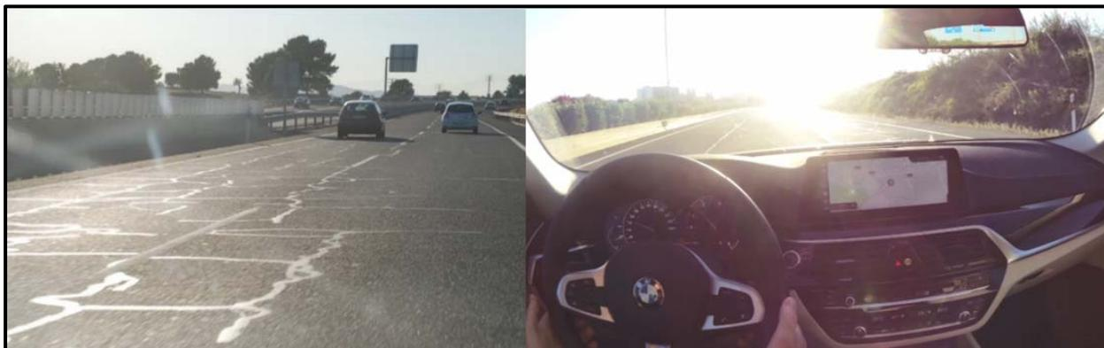
Figura 75. Sellado de fisuras longitudinales del pavimento.
