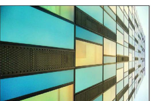
Fachada metálica perforada
