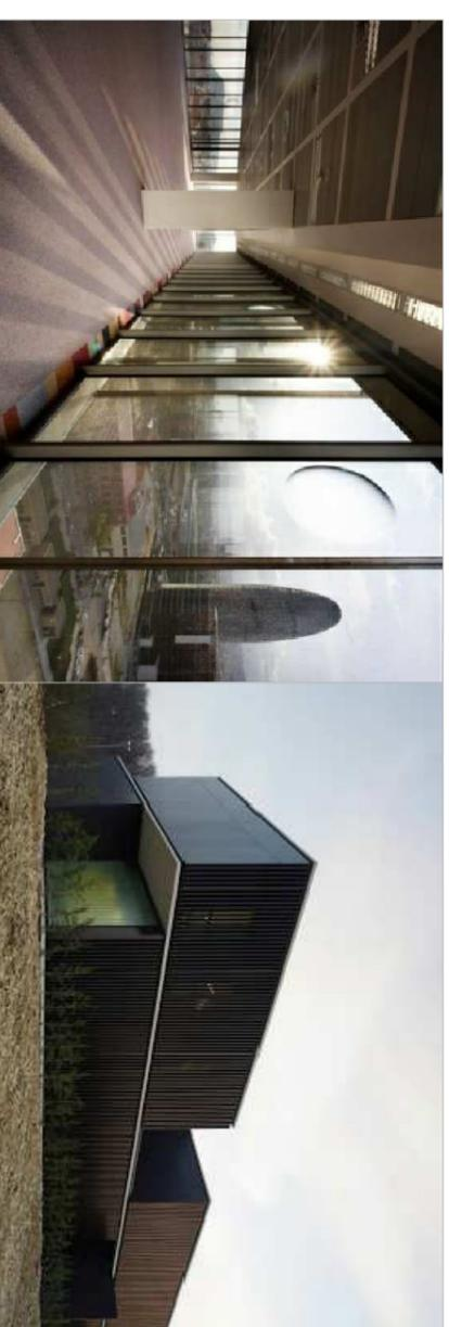
Fachada de muro cortina perimetral combinado con lamas metálicas verticales para protección solar
