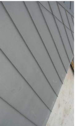
2. Cubierta no transitable con acabado de zinc con junta alzada. Cubierta a dos aguas color anticada
