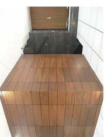
Revestimiento exterior de madera de cedro en los núcleos húmedos y en salas de ensayo.
