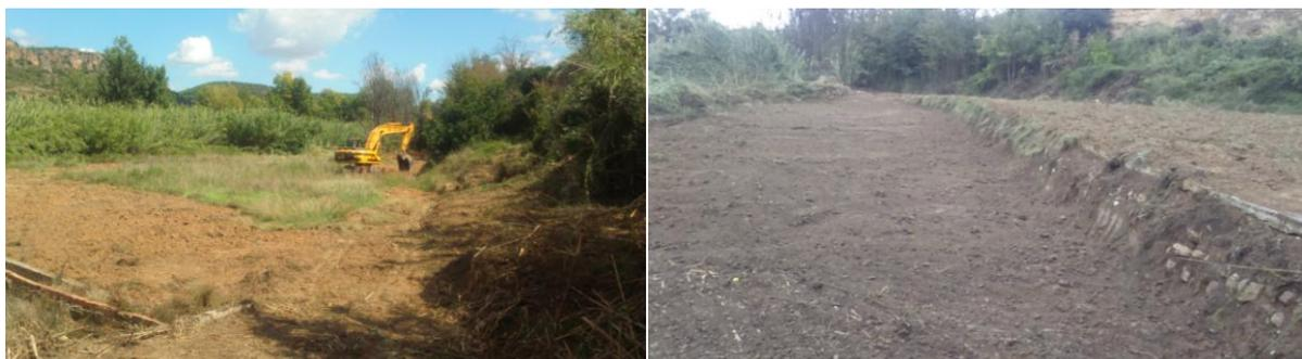
**Figura 8.** Desbroce del terreno con maquinaria pesada (Elaboración propia, 2018).
