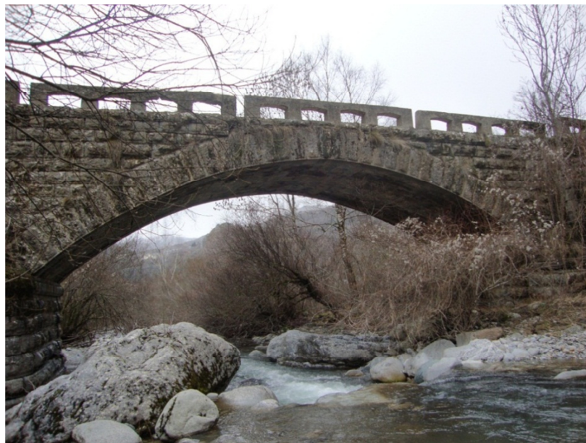
Imagen 72: Puente del Concellar.
