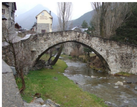
Imagen 75: Puente del Paco desde la margen derecha del río.
