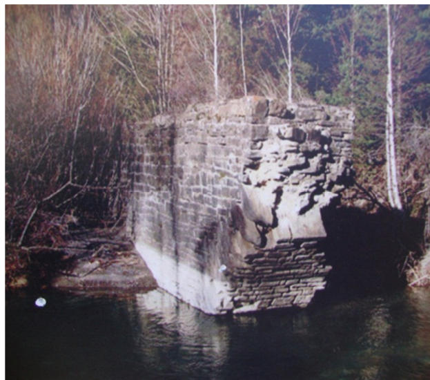
Imagen 77: Puente de Molat. Arranque de estribos.
