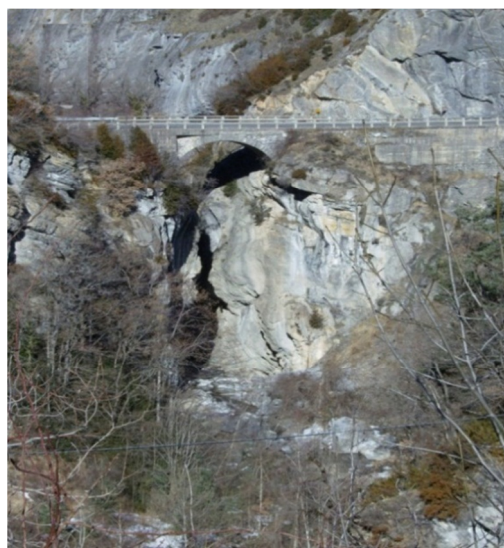
Imagen 74: Puente de Escarrilla.
