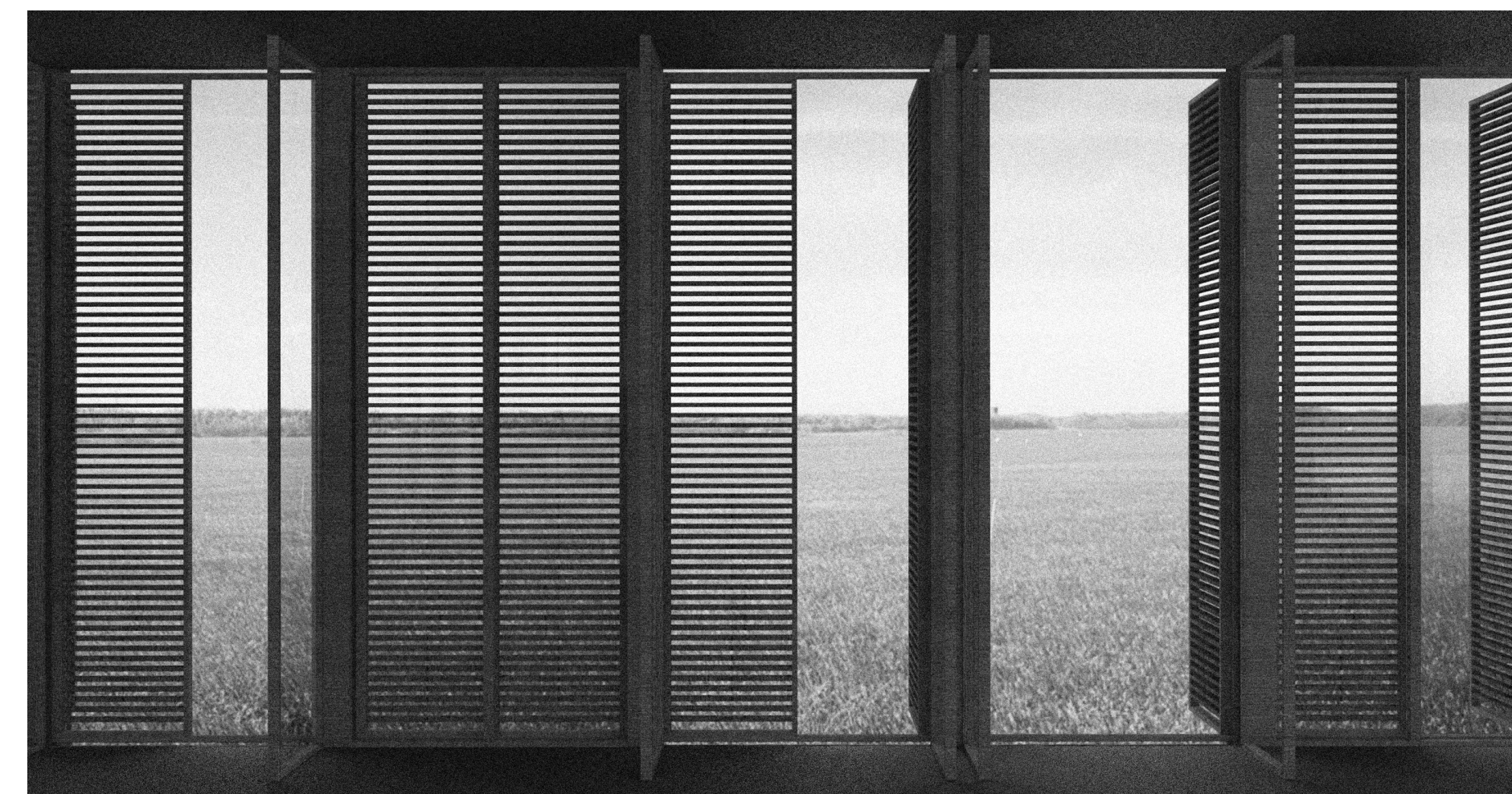
Detalle de la fachada
