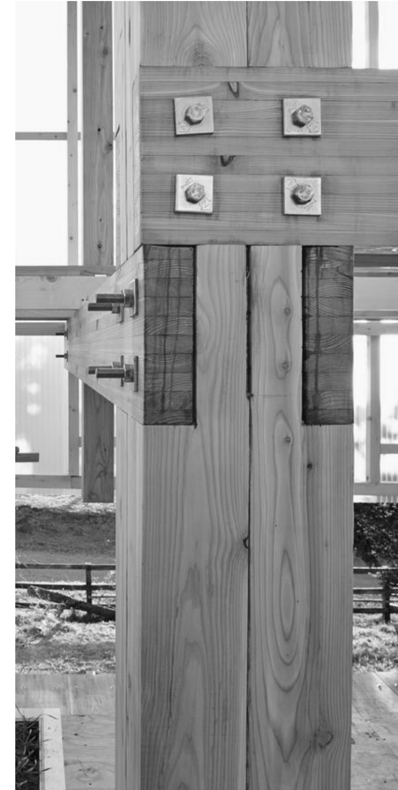
Detalle utilizado en viga de madera - viga de hormigon
