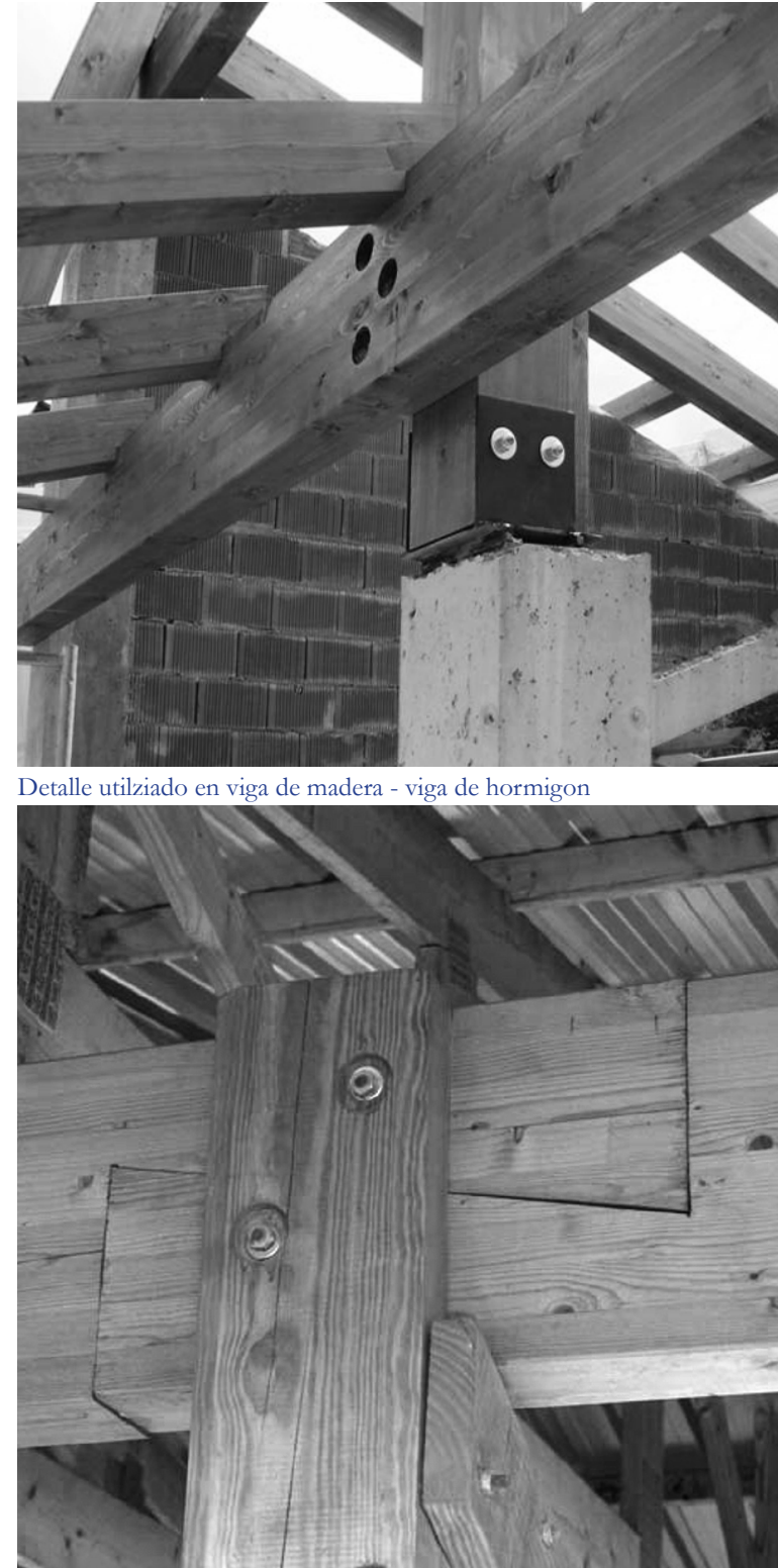
Encuentro utilizado en cercha con pilar
