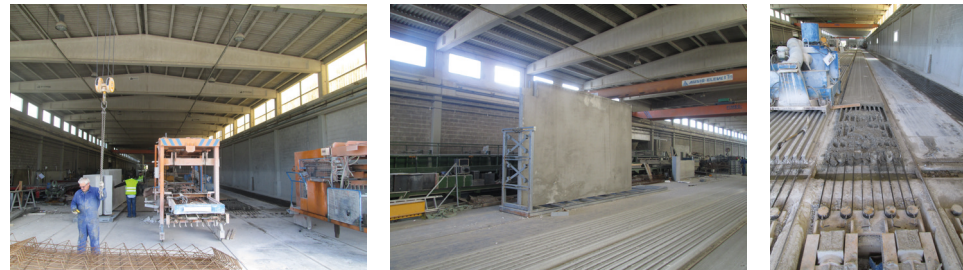
Instalaciones de prefabricados en Benicarló. Pista de pretensados y elementos de gran tamaño.
