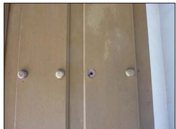
Decoloración de la puerta, falta clavo cabezote.
