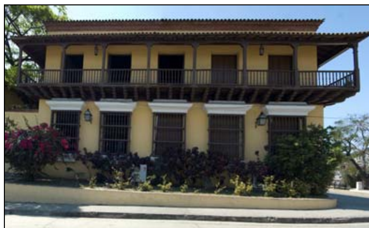
Vista general de la Fachada lateral
