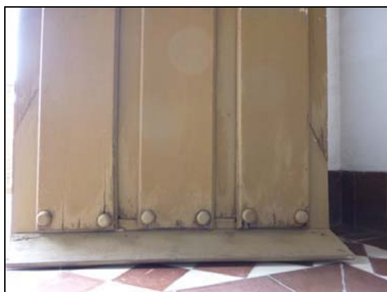
Decoloración de la puerta, falta clavo cabezote.
