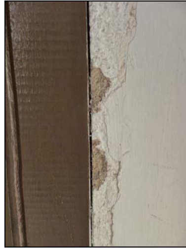
Puerta de acceso desde el Zaguán a Dirección, con falta de material en la unión marco - pared
