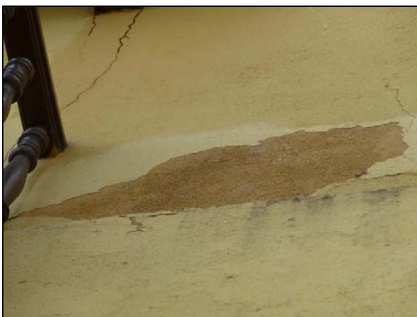
Fisuras, desconchados
