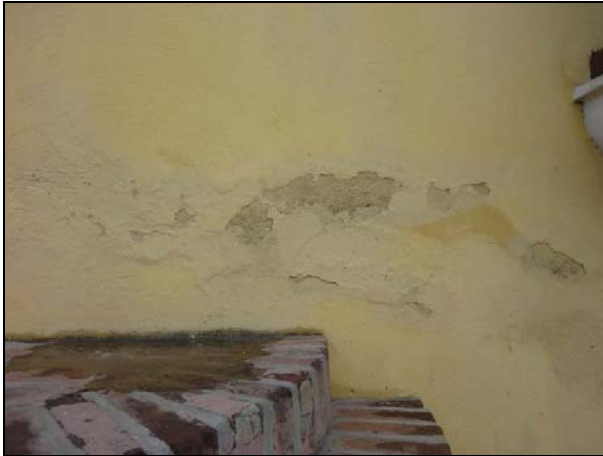
Manchas de humedad, desconchados y abolsamientos
