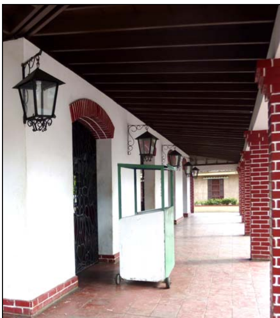
Techo que cubre el corredor
