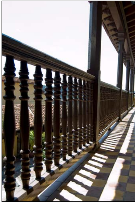
Barandilla de los Balconajes
