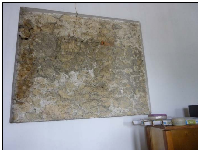
Muro de Mampostería en Sala Técnico
