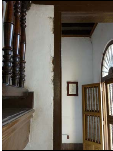
Puerta de acceso desde el Zaguán a Dirección, con falta de material en la unión marco - pared
