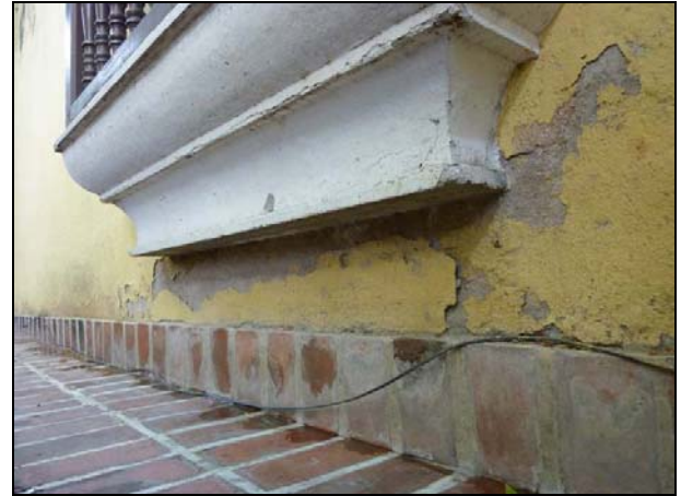
Humedad por capilaridad, desprendimientos del material de recubrimiento
