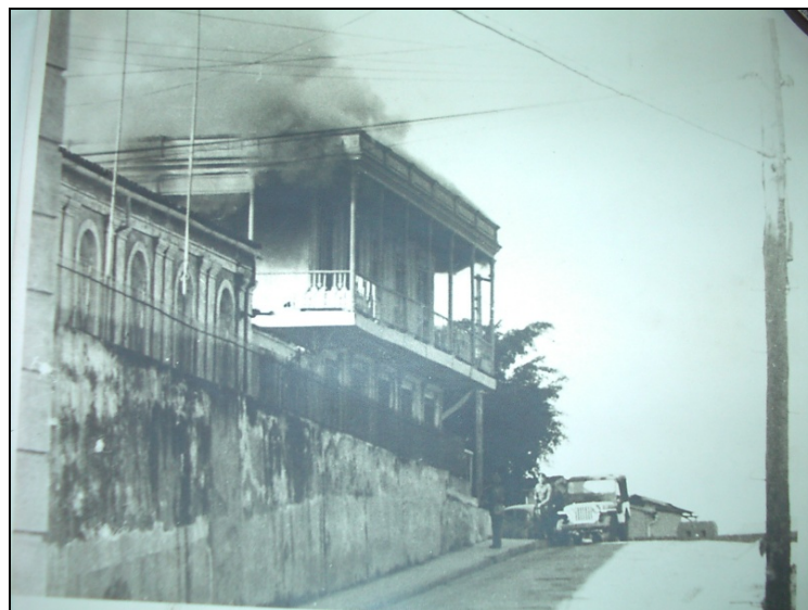
Fotografía de 1956. Balcón corrido realizado con estructura metálica (En los años cincuenta del siglo XIX, para dar una apariencia de arquitectura neoclásica, se sustituían los barrotes y balaustres de madera por otros de hierro forjado en balcones, balconajes, ventanas)
