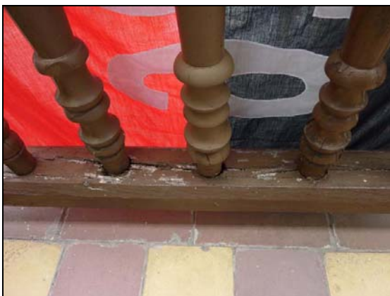
Travesaños fracturado
