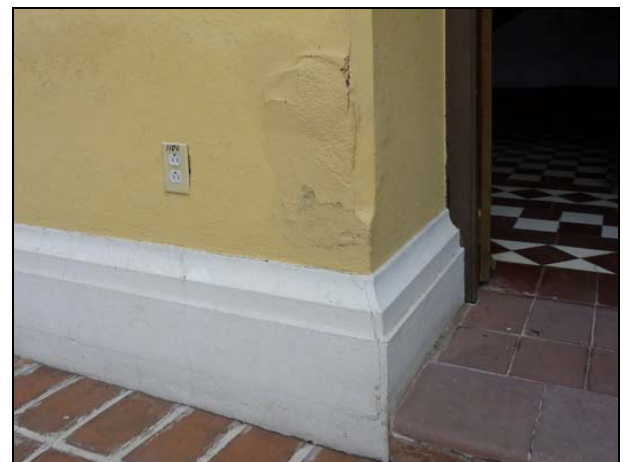
Abolsamientos y desconchados en muros
