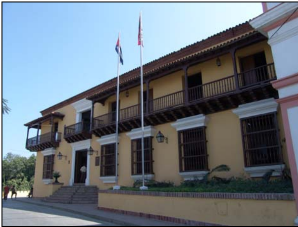
Fachada Oeste. Calle Rabí nº 1
