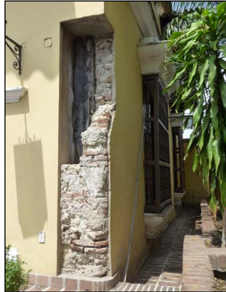
Horcón en Fachada Este
