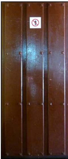
Detalle de puerta
