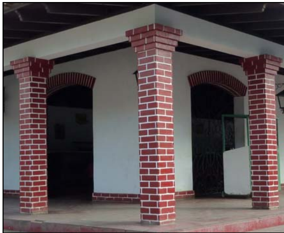
Detalle del pilar
