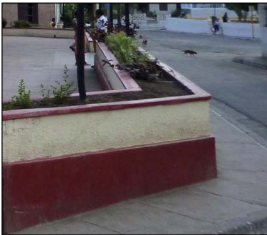
Detalle de murete
