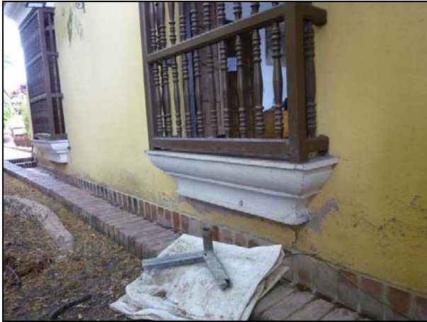
Humedad por capilaridad, desprendimientos del material de recubrimiento
