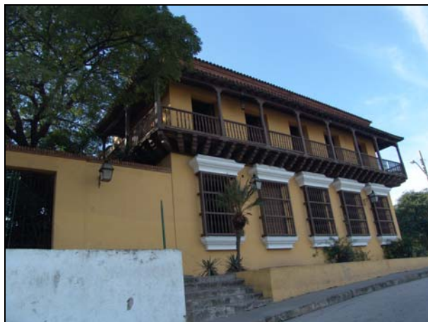
Fachada Norte (fachada lateral)
