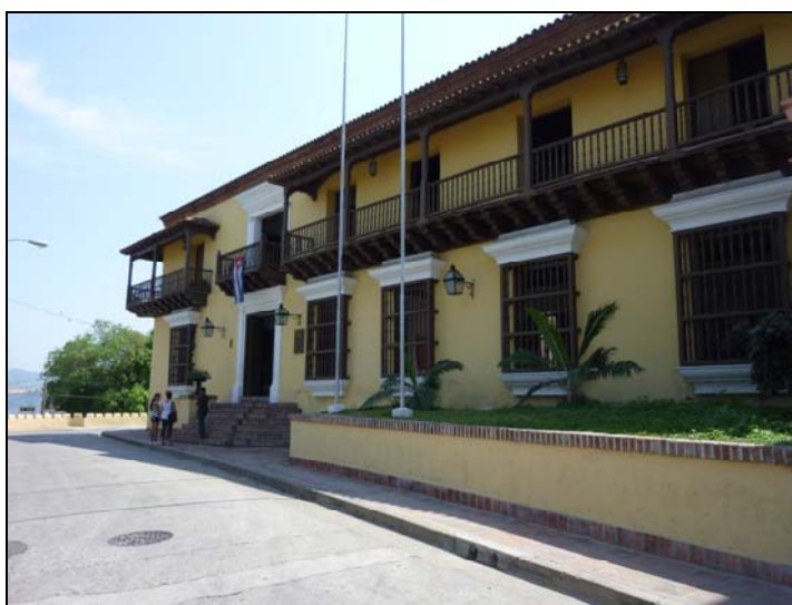
Vista general de la Fachada Principal
