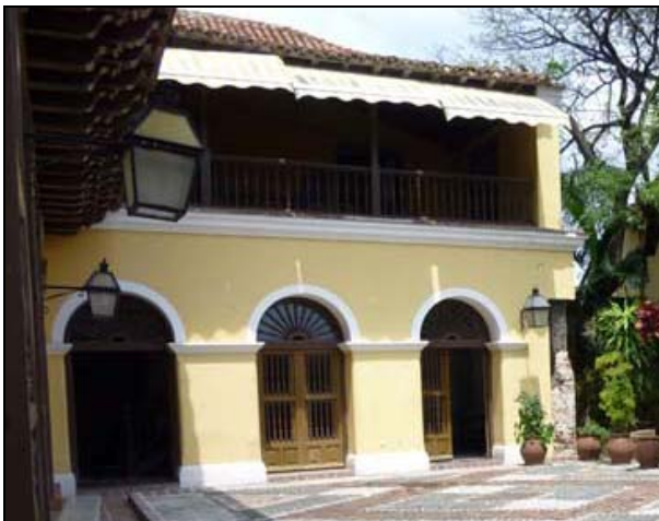
Fachada Norte recayente al patio
