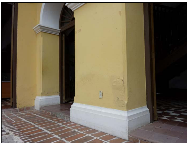
Abolsamientos y desconchados en muros
