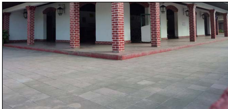
Fotografía general del pavimento exterior
