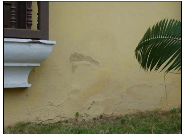
Manchas de humedad, desconchados y abolsamientos
