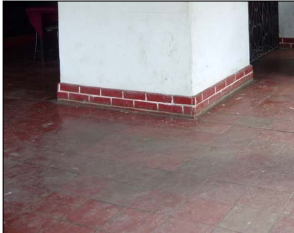
Detalle de pavimento y rodapié
