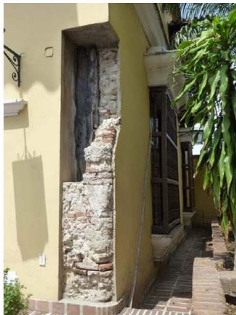
Muro de mampostería visto
