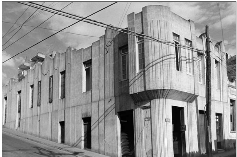
Edificio en Reloj esquina con San Jerónimo
