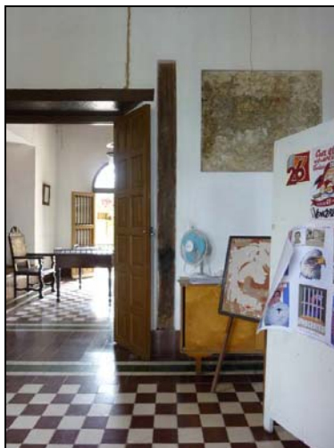
Horcón visto. En la parte superior del dintel reguero de comején
