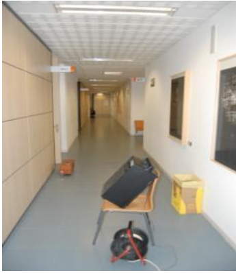
Fuente en pasillo (Partición A)
