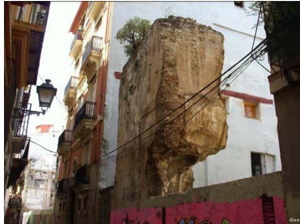
Restos muralla musulmana. Calle Salinas.
