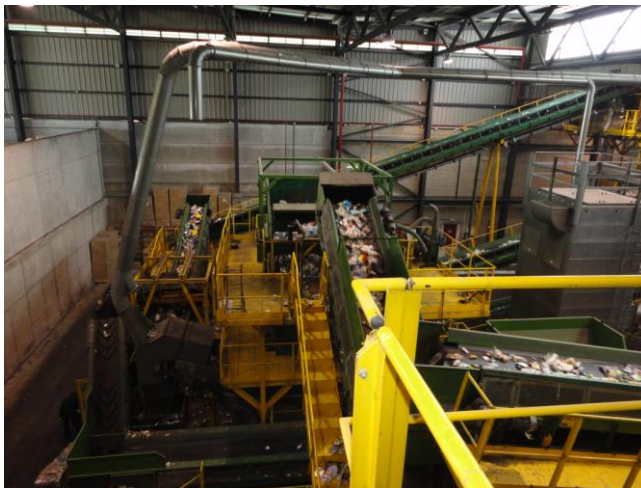
Vista interior de la planta
