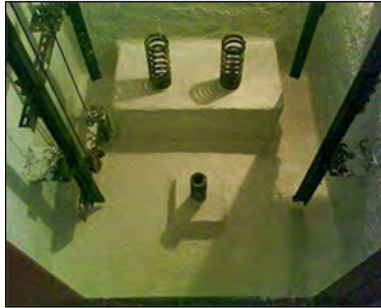
Figura 23 Amortiguadores de ascensores
