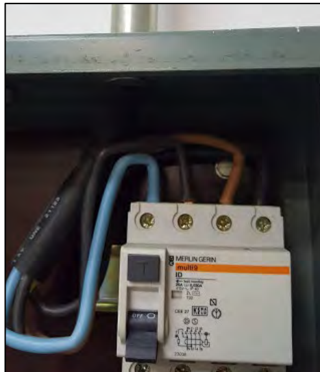
Figura 103 Montaje de protección a la red eléctrica
