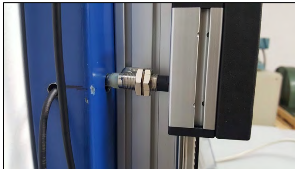
Figura 105 Montaje de los sensores de posicionamiento
