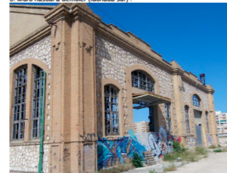
3. Muro hastial a demoler (fachada sur).
