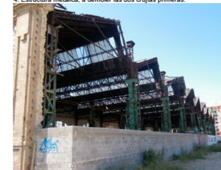
4. Estructura metálica, a demoler las dos crujeas primeras.
