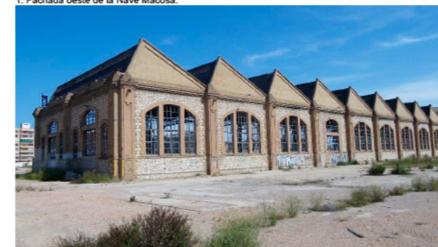
1. Fachada oeste de la Nave Macosa.
