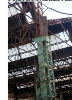
5. Detalle de unión estructural a desmontar.
