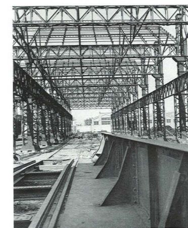
Ampliación, levantamiento de naves de máquinas-herramientas, vista desde el Sur, con el trasbordador DEVIS de 60 Tn (1936). C.F. nº 68
