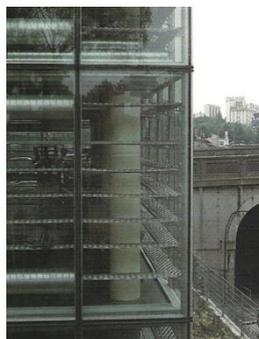
Una variante de este sistema son las fachadas de doble piel; aquí el vidrio sencillo se coloca al exterior, formando un vacío delante de la fachada.
