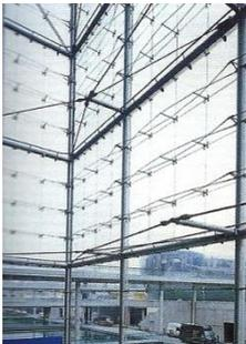
El tipo de fijación y la junta de silicona permiten además que la estructura base sea bastante deformable, pudiéndose desarrollar los conocidos ejemplos de soportes mediante sistemas tensados.
