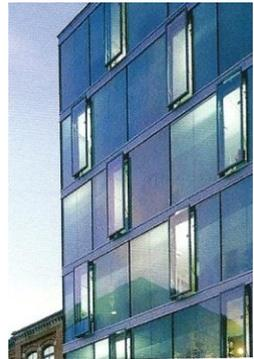
*Fig. 86 Novedoso sistema de ventanas proyectantes se incorpora en este edificio de oficinas de Esslingen. (O. Reutter, 2003)*
