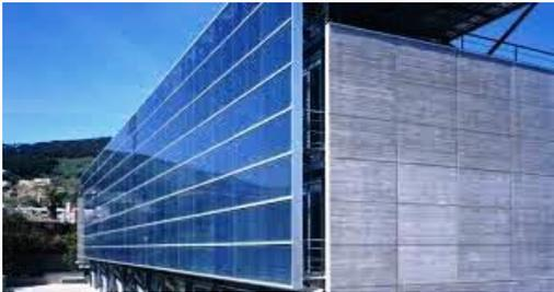
*Fig. 108 Parque de Innovación Tecnológica La Salle, Barcelona. Vista exterior de la fachada de doble piel y de la pérgola en cubierta. De la superficie total sólo un 30% son auténticas placas fotovoltaicas de silicio policristalino sobre vidrio transparente, el resto es vidrio serigrafado. (Fuente: [www.salleurl.edu](http://www.salleurl.edu))*
