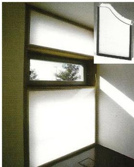
Los gases inertes como el argón, el xenón o el criptón reducen todavía más el factor de conducción y dificultan la convección.
