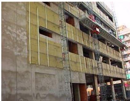
La subestructura de dos órdenes de perfiles puede interesar también cuando se reduce el número de anclajes a borde de forjado o a frente de pilares, separando entre sí los perfiles más de lo que admite la inercia de los paneles.
