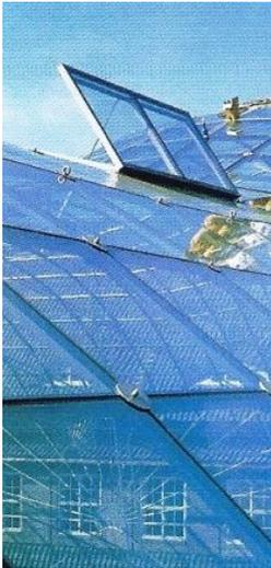
Debido a la presencia de materiales plásticos, metales, adhesivos y sellantes, debe existir una tendencia en el diseño a evitar la degradación y corrosión afectando, eso sí, a la solución en juntas y fijaciones así como a la elección de los materiales idóneos.
