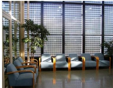
*Fig. 111 La fachada principal, orientada al sur, con el muro cortina modular fotovoltaico y con una superficie total de 225 m<sup>2</sup> Arquitecto: Miguel Brullet. Año de construcción : 1996 (Fuente: culturamataro.cat)*
