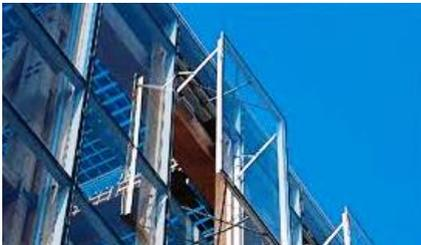
*Fig. 109 Academia Mont Genis, Herne (Alemania). Ventanas con aperturas de tijera paralela. Los paneles son células de silicio cristalino sobre Tedlar transparente, con porcentaje de transmisión luminosa variable entre el 47% y el 7%, dependiendo de la distancia entre células. (Fuente: [www.wicona.com](http://www.wicona.com))*
