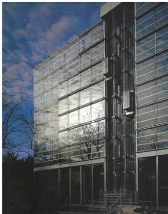
El uso de sistemas exteriores de protección solar es un buen ejemplo de un planteamiento multicapa de la fachada, en el que no hay un único elemento que solucione todos los problemas. La ampliación del IRCAM (París, 1988-1989) de Renzo Piano o la Fundación Cartier de París (1991-1994) de J. Nouvel y Cattani proponen este tipo de solución.
