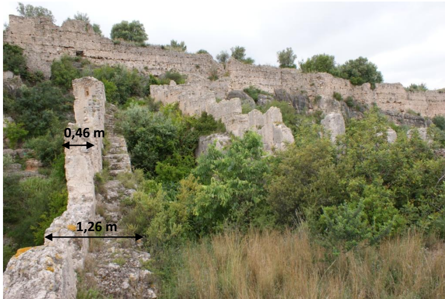
Fotografía 41. Interior del muro de enlace, visto desde la torre albarrana
