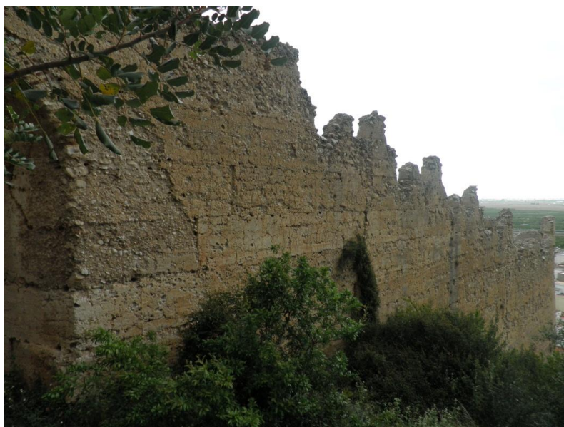
Fotografía 43. Torre albarra y muro de enlace desde la parte noroeste
