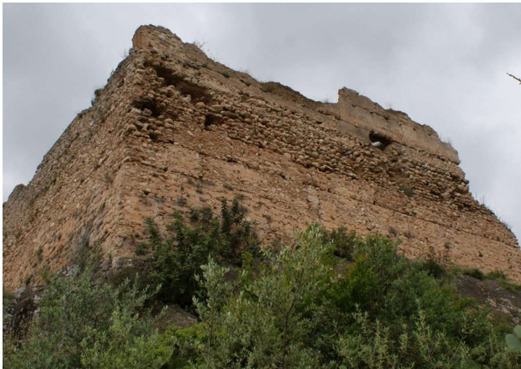
Fotografía 60. Parte oeste del castillo. Tapia 90 cm de altura cada módulo y mampuesto de gran tamaño
