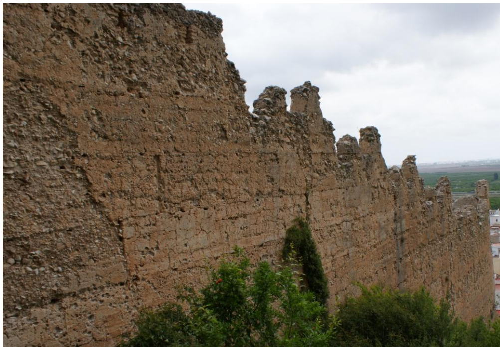
Fotografía 61. Muro de enlace. Tapia de 80 cm de altura cada módulo y mampuesto pequeño
