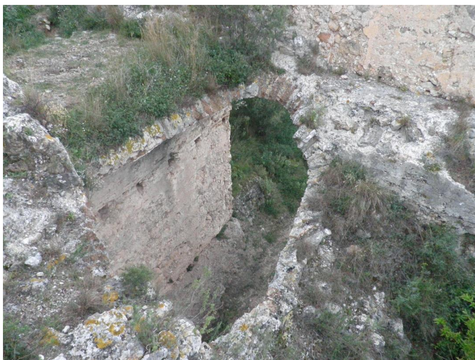
Fotografía 28. Agujero de la bóveda visto desde arriba.
