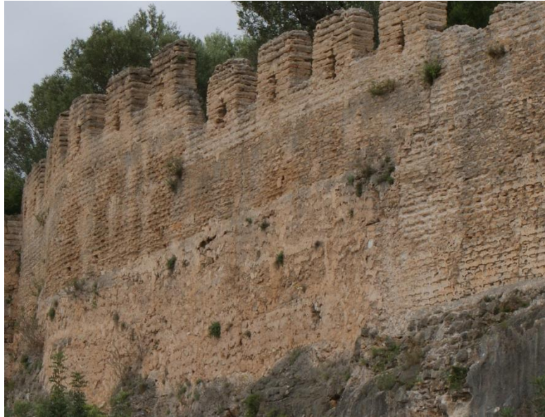
Fotografía 57. Muralla norte, donde se aprecia el cambio de época
