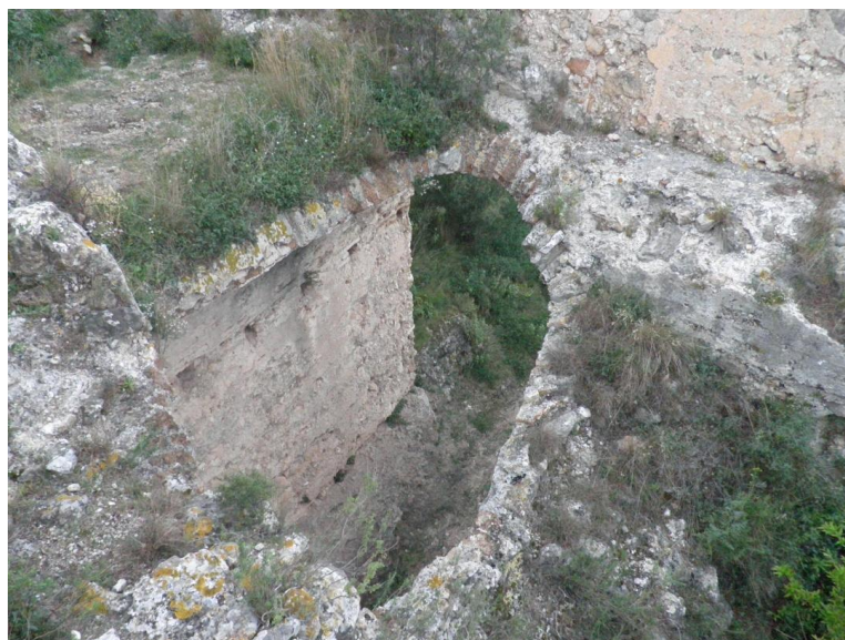
Fotografía 40. Vista de la bóveda tomada desde arriba
