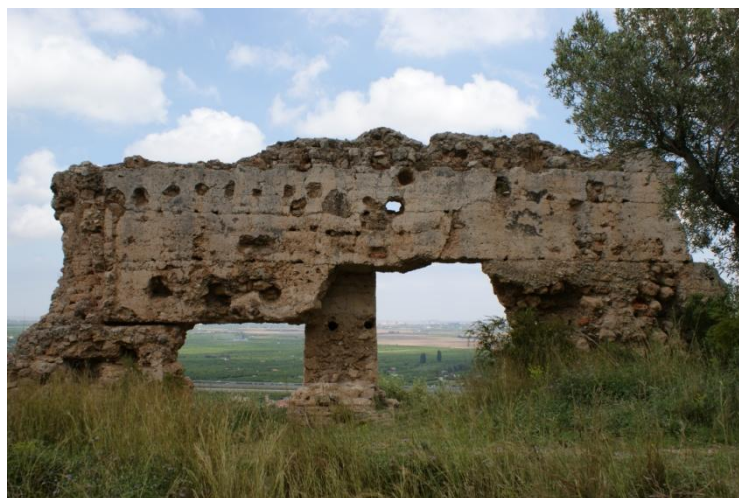
Fotografía 36. Muro este de la Torre del Homenaje (vista interior).
