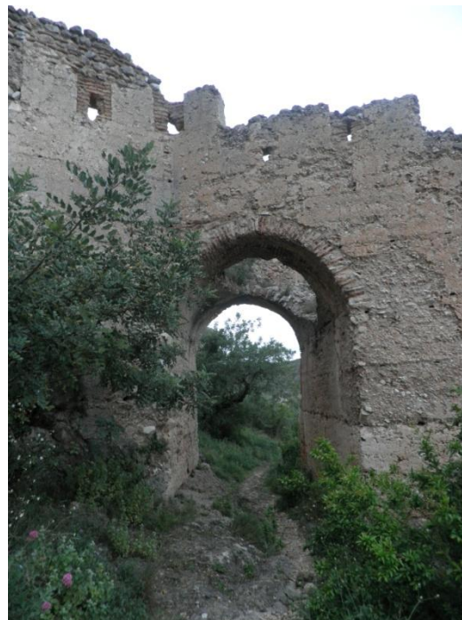
Fotografía 39. Bóveda de acceso a la entrada
