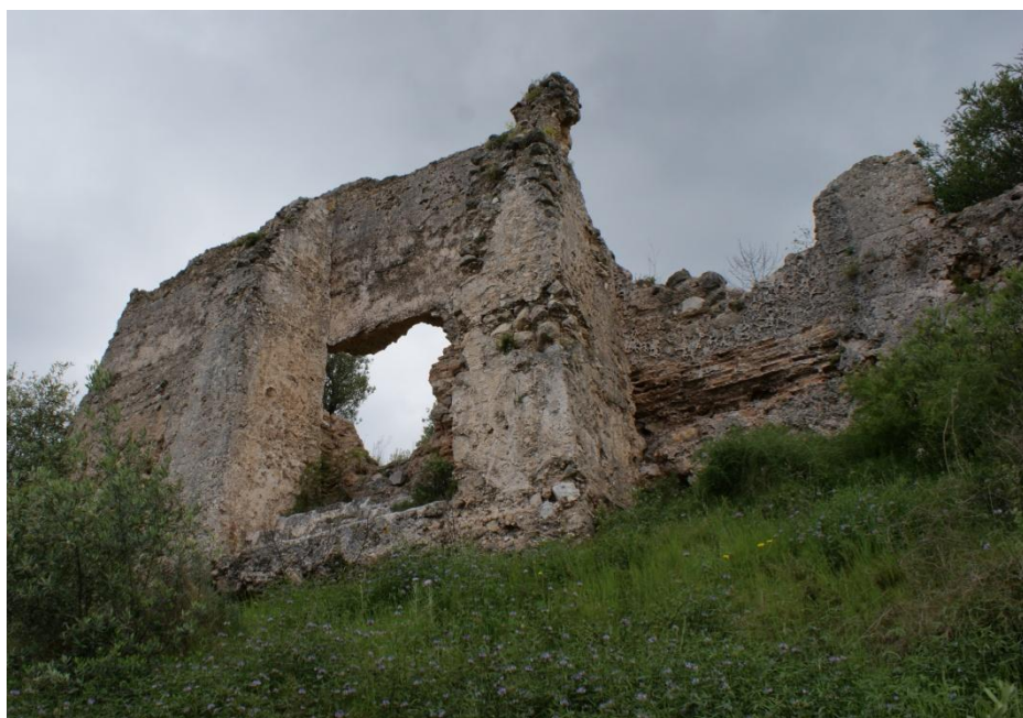
Fotografía 37. Muro este de la Torre del Homenaje. (vista exterior)
