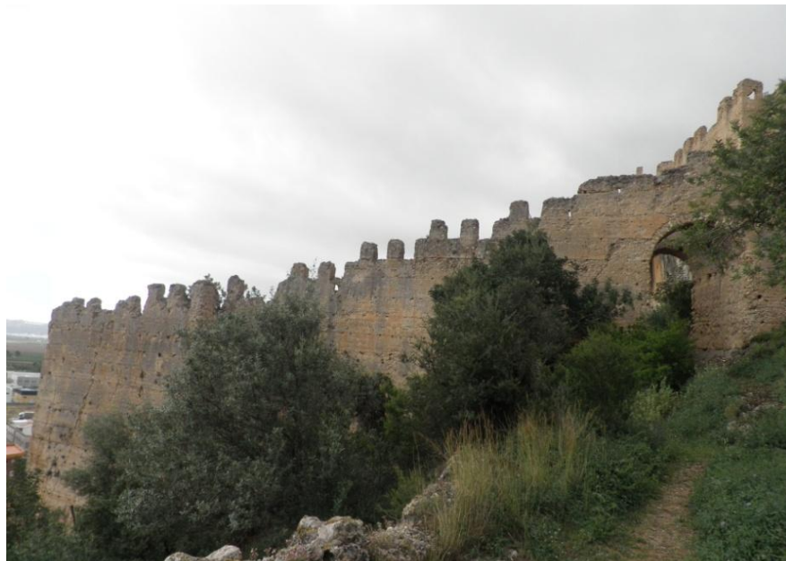
Fotografía 42. Torre albarrana y muro de enlace desde la parte noreste
