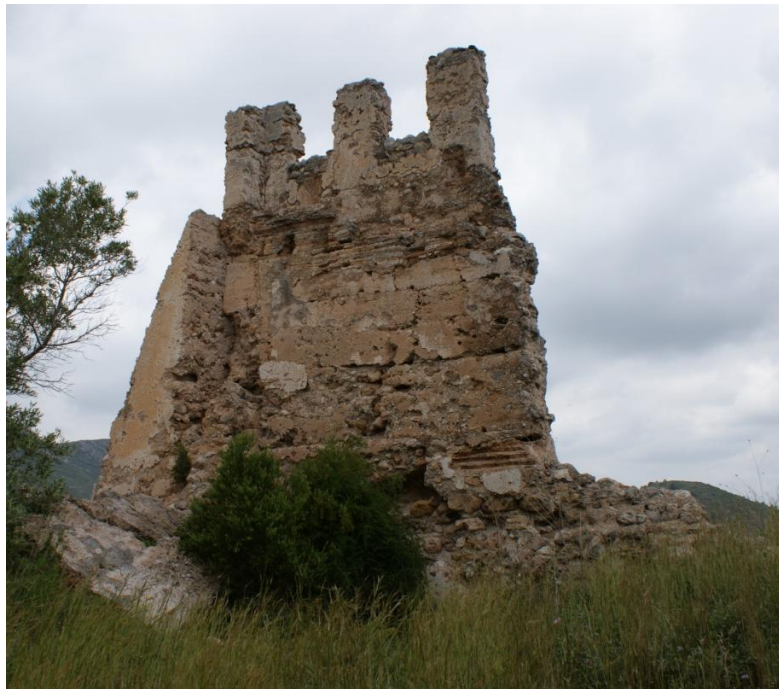
Fotografía 35. Muro norte de la Torre del Homenaje, enlazando con el muro norte (vista interior)
