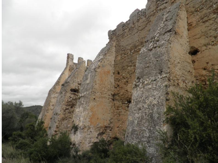
Fotografía 34. Muro oeste que formaba parte de la "torre del homenaje"
