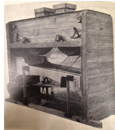
Limpia separadora del germen y pequeños fragmentos de la elaboración del arroz (modelo Torrejón)
