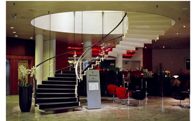
Las escaleras junto al ascensor son de hormigón armado, las huellas de la misma son de piezas de hormigón pulido y la barandilla también quedará anclada a la estructura de la escalera.
