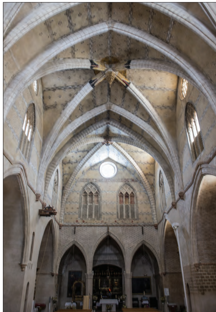
(LA) Vista hacia el ábside
