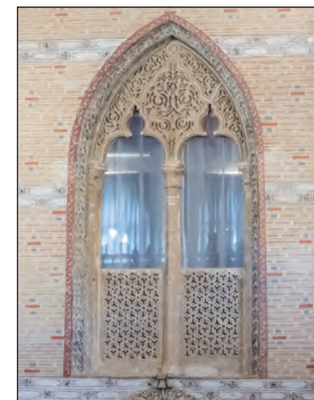
(LA) Ventana sobre el ábside
