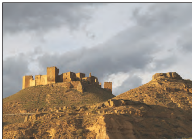
Vista desde el oeste
