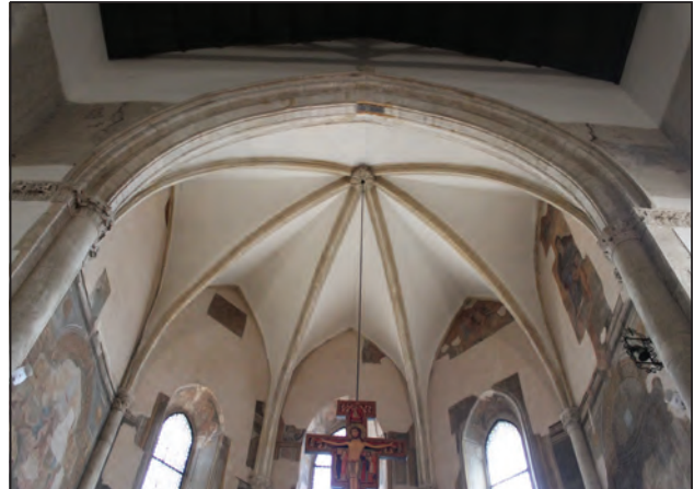
Bóveda sobre el ábside
