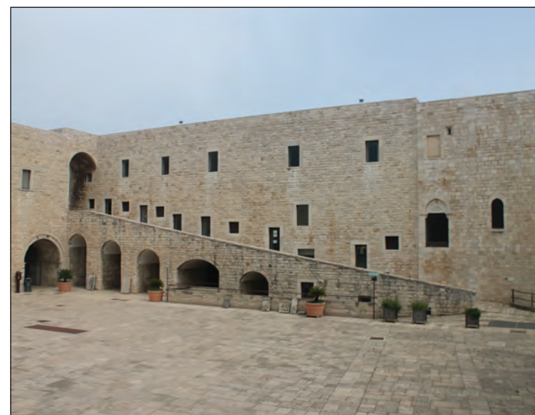
Rampa del patio
