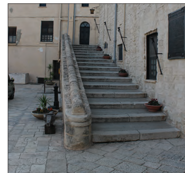
Detalle de la escalera del patio
