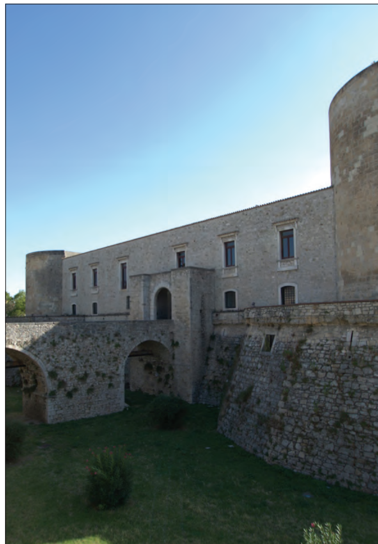
(LA) Puente sobre el foso y acceso
