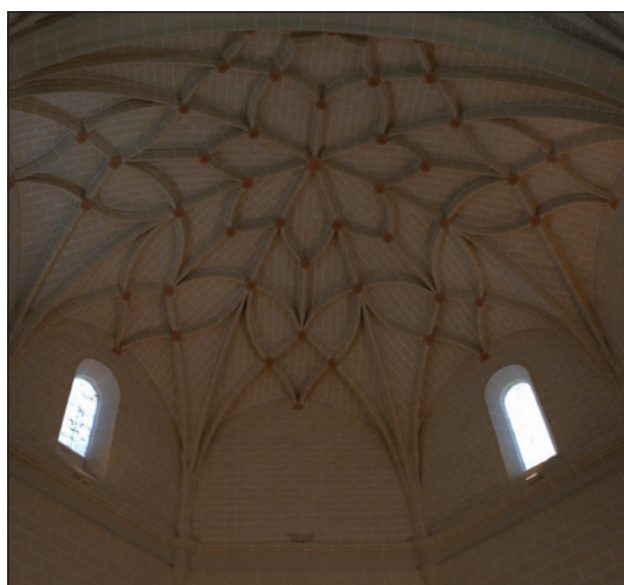
Bóveda del ábside
