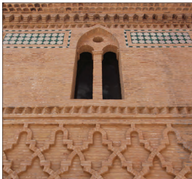
Detalle de la fachada
