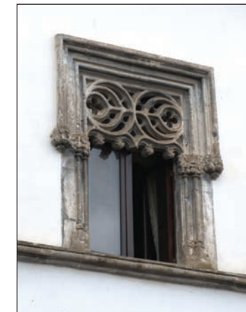
(LA) Ventana de la fachada norte
