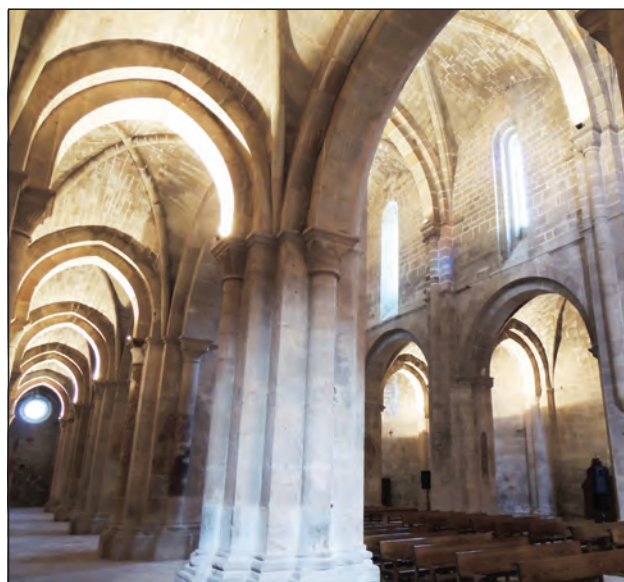
Interior de la iglesia
