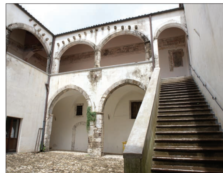
(LA) Escalera del patio
