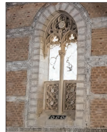
(LA) Detalle de una ventana
