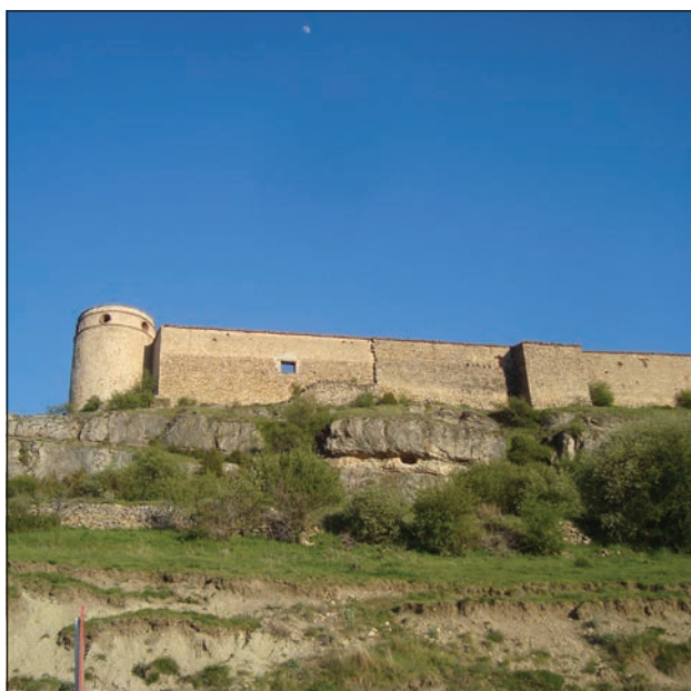
Vista desde el oeste
