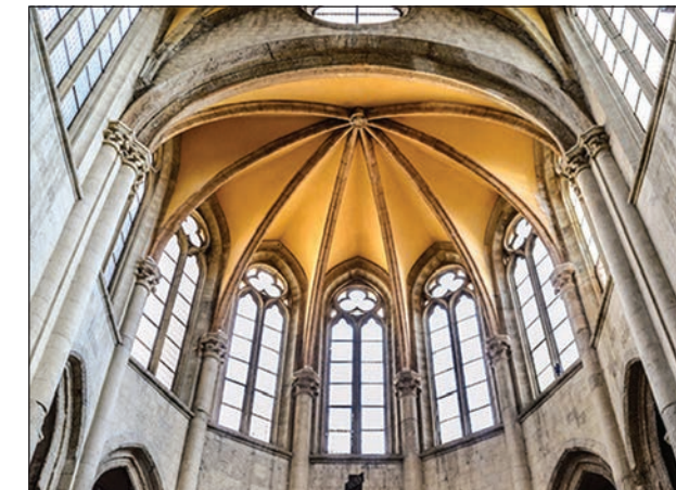
(APM) Bóveda del ábside
