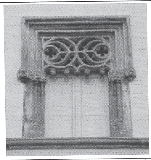
Finestra della stanza ad angolo adiacente alla sala delle udienze.
