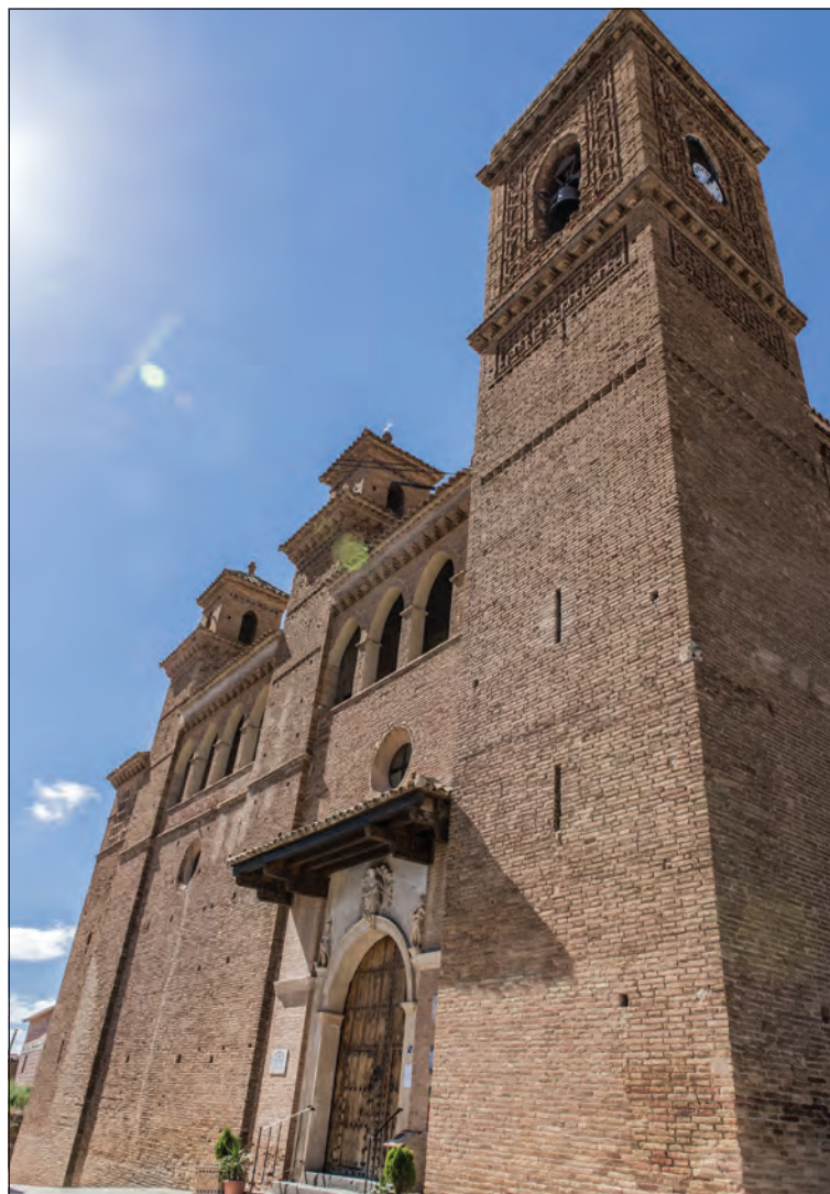
(LA) Acceso en la fachada oeste
