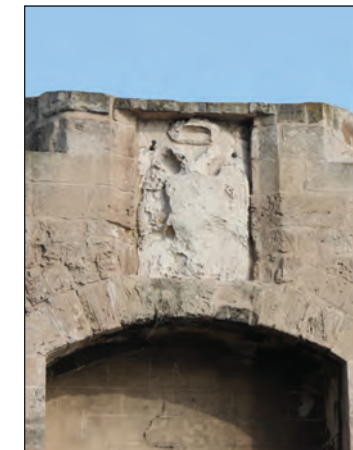
Detalle del acceso desde tierra
