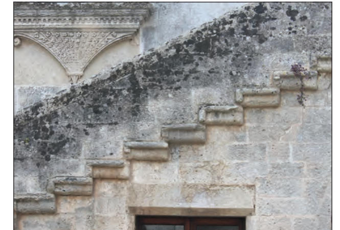
Detalle de la escalera del patio
