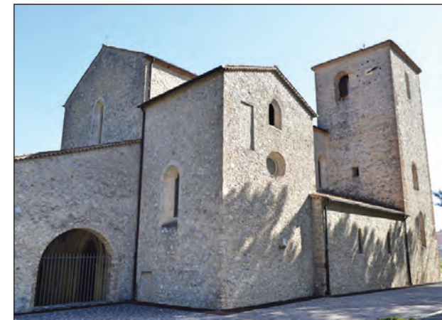
Vista del conjunto desde el noroeste
