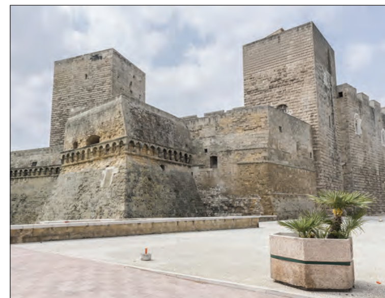
(LA) Torre y bastión noreste
