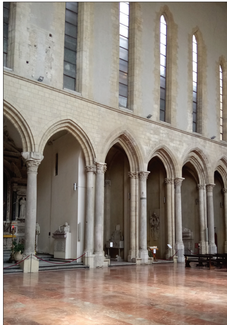
Nave y capillas laterales (lado del evangelio)
