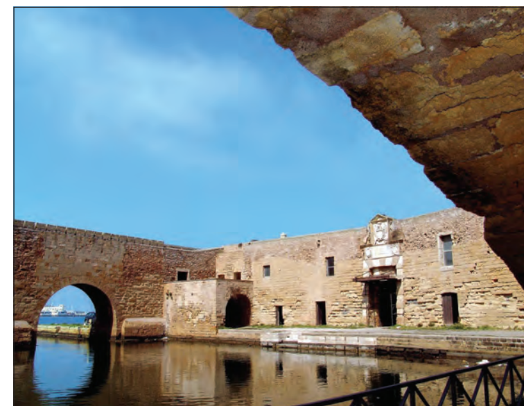
Entrada a la dársena desde el interior
