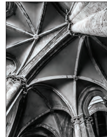
(APM) Bóvedas del deambulatorio
