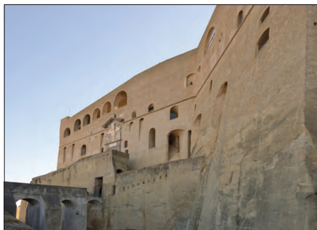
Vista del acceso
