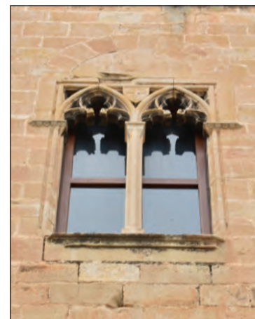
Bífora del alzado oeste
