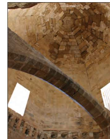
Bóveda de la torre sureste
