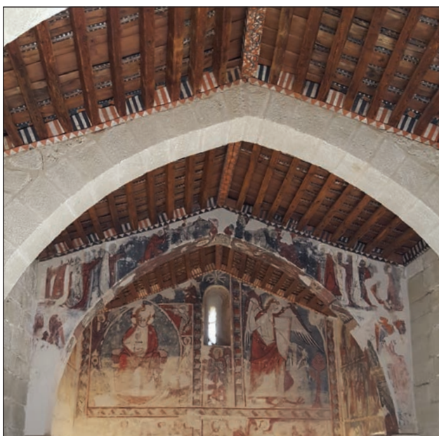
Detalle de la cubierta y arcos diafragma
