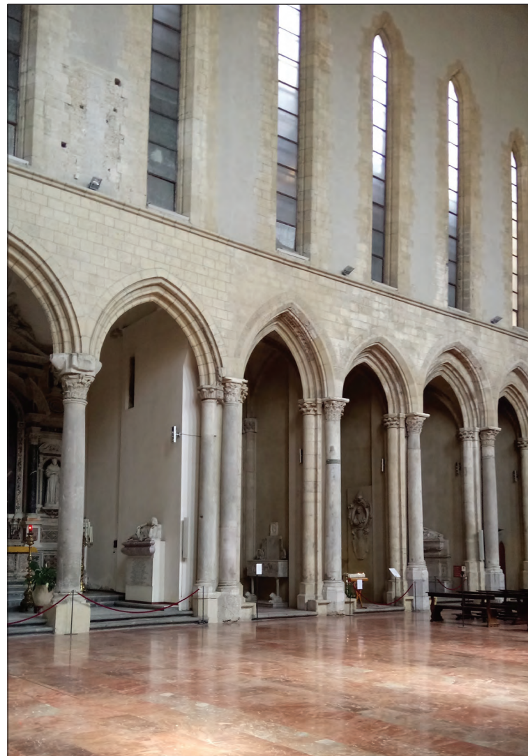
Nave y capillas laterales (lado del evangelio)
