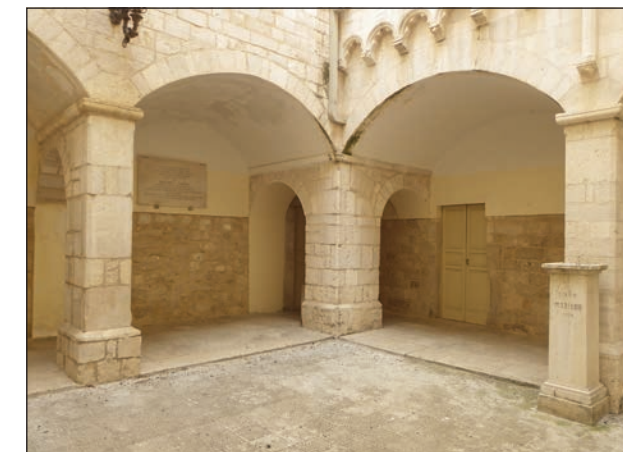
Esquina noreste del patio
