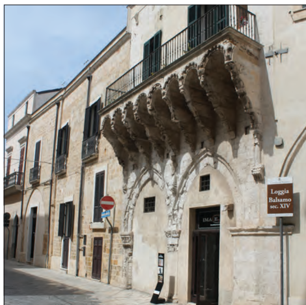
Loggia de la fachada sur
