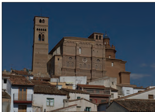
Vista desde el oeste
