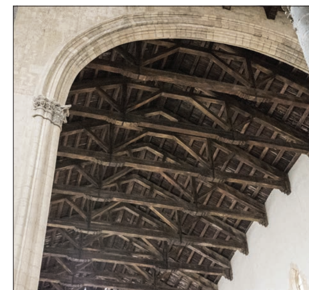
(LA) Detalle de la armadura de la nave desde el transepto
