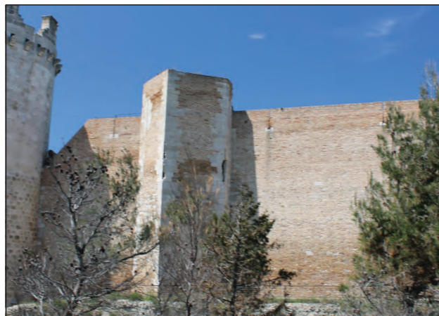
Detalle de uno de los torreones (22) de ladrillo
