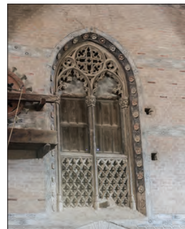
(LA) Ventana de la fachada este
