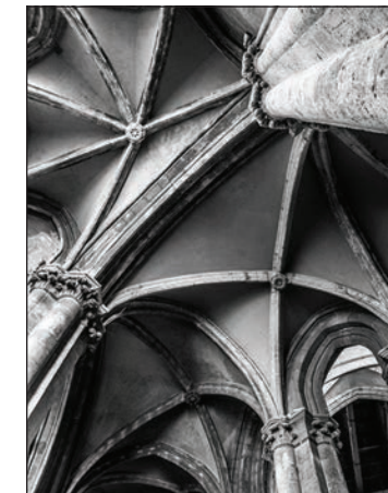
(APM) Bóvedas del deambulatorio
