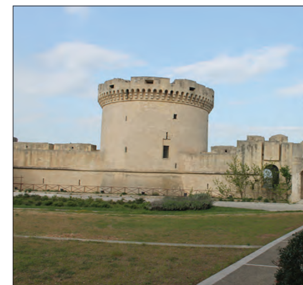
Torre central desde el interior
