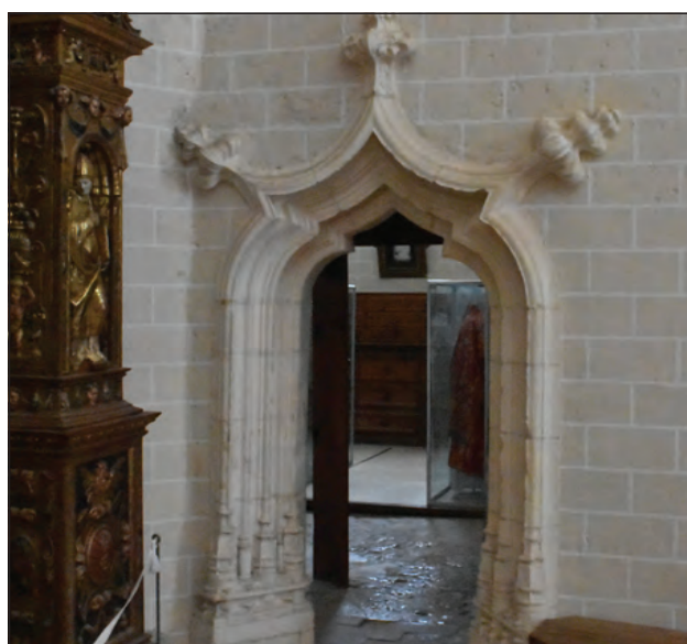
Acceso a la sacristía
