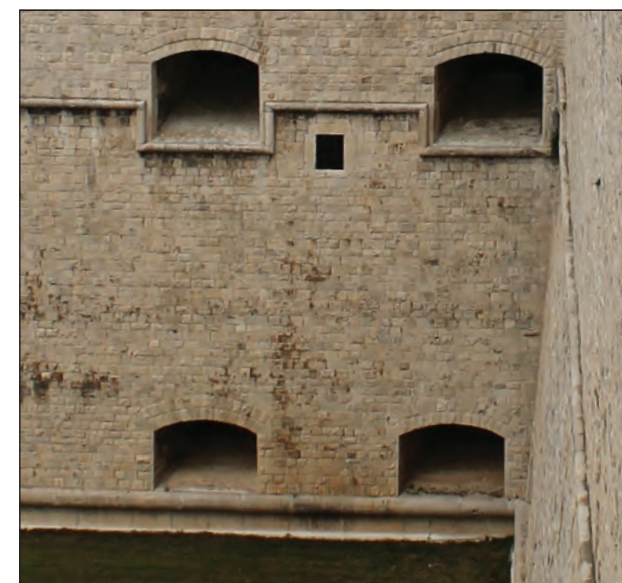
Detalle de los dos niveles de cañoneras
