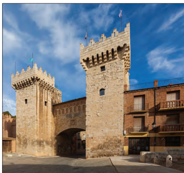
Vista desde el exterior del recinto
