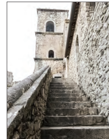
Detalle de la escalera
