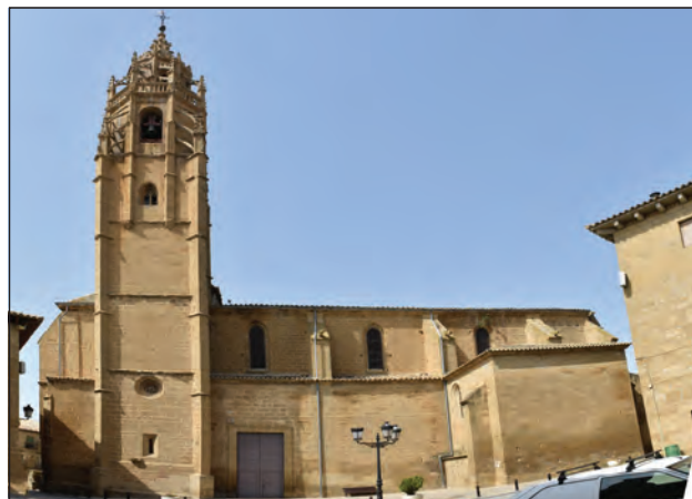
Fachada sur y campanario
