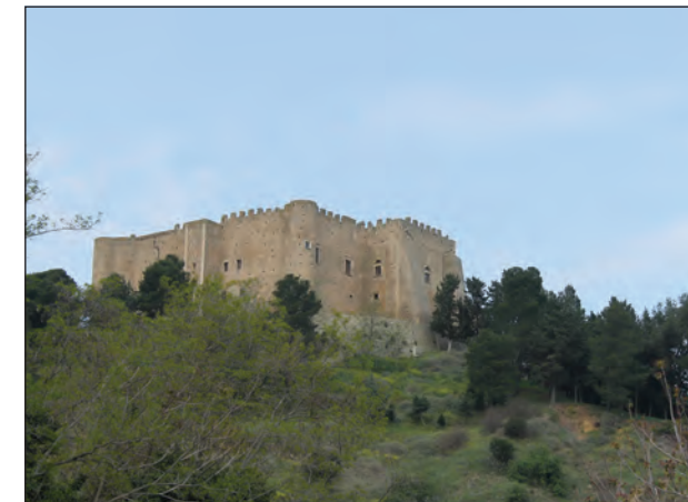
Vista del conjunto desde el sur
