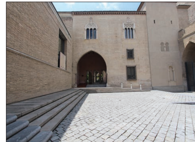
(RSJ) Primer patio
