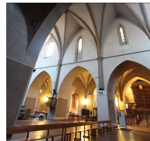
Nave central desde la del evangelio
