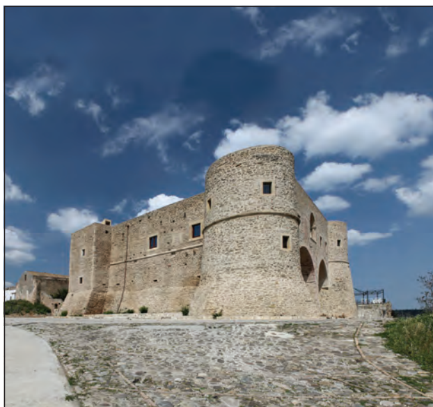
Lienzo oeste y torre suroeste
