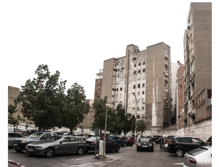
Parking público ubicado en el terreno de estudio. 2013.
