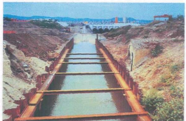
**Figura 34.** Rampa de lanzamiento protegida con tablestacas.
