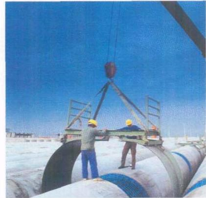
*Figura 21. Hormigonado de las conexiones entre tubos.*
