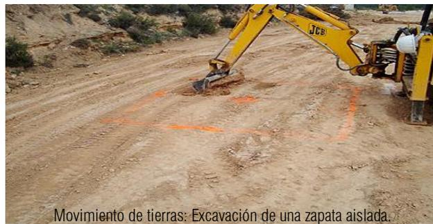
Movimiento de tierras: Excavación de una zapata aislada.
