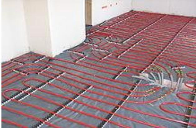
Tuberías para un sistema de calefacción por suelo radiante, antes de montar el pavimento.
