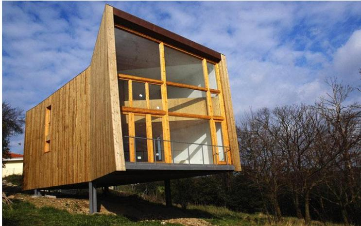
Vivienda con estructura mixta de acero y madera, desmontable y reciclable.
