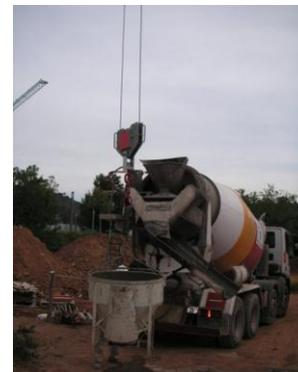
Grúa torre enganchando el cubilote de hormigonado.
