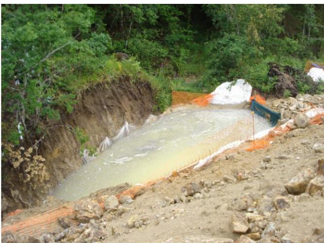
Creación en obra de una balsa de decantación protegida de las pérdidas mediante plásticos.
