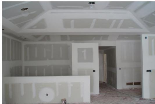
Tabiquería y falso techo realizado mediante piezas prefabricadas de yeso
