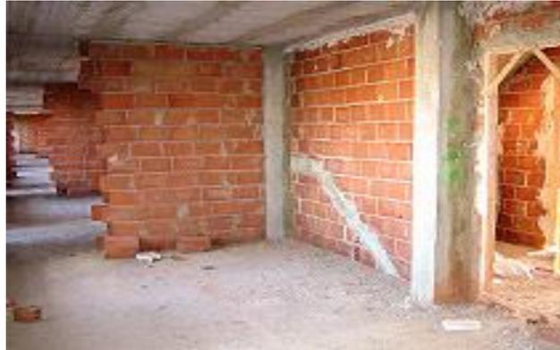
Ejecución de tabiquería interior mediante ladrillo cerámico hueco.
