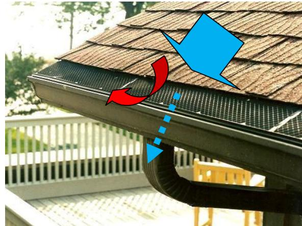
Canalones del tejado con protección mediante mallas
