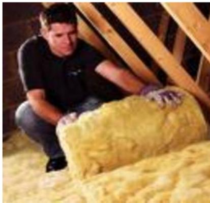
Colocación de aislante térmico en el interior de una cubierta que posee cámara de aire.
