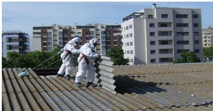
Eliminación de la cobertura de una cubierta formada por amianto.
