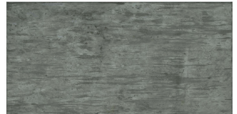
CEMENTO PULIDO TONOS GRISES COLOCADO EN PAVIMENTO DE INTERIOR
