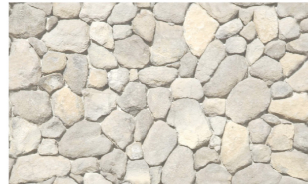
MURO DE MAMPOSTERÍA COLOCADA BASAMENTO DE HABITACIONES
